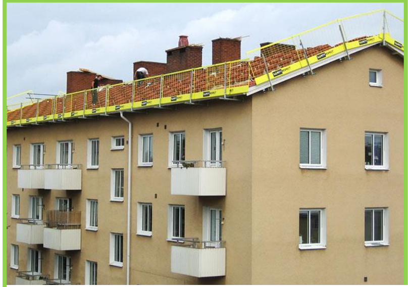
Şekil 5.7. Çatı çalışmasında düşmeye karşı koruma [34]
