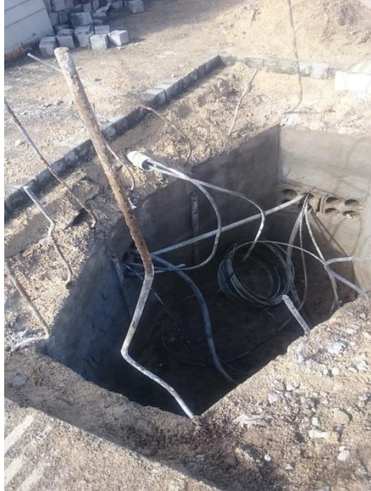
Resim 2.4. İçinde elektrik hatları da olan bir çukur
