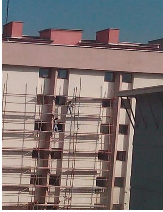
Resim 2.3. Bir inşaatta korkuluk üzerinde çalışma
