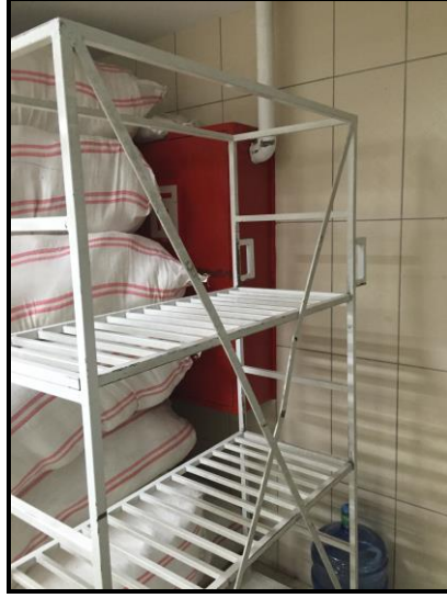
Resim 4.15. C oteli amařrhanesinde nne malzeme istiflenmiř yangın dolabı
