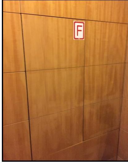
Resim 4.17. D oteli misafir katlarında bulunan yangın dolapları
