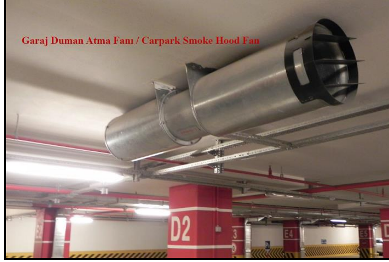
Resim 4.26. A oteli kapalı otopark duman atma fanı
