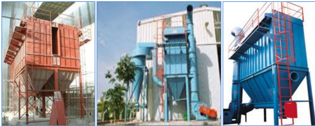
Resim 2.13. Torbalı tip jet filtreli toz tutma sistemleri [20]
