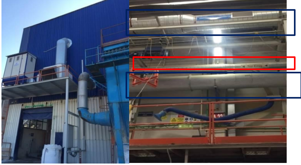
Resim 4.7. Yaş tip toz tutma sistemi ( Kırmızı ile belirtilen toz emiş kanalı, lacivert ile gösterilen temiz hava üfleyen kanallar )
