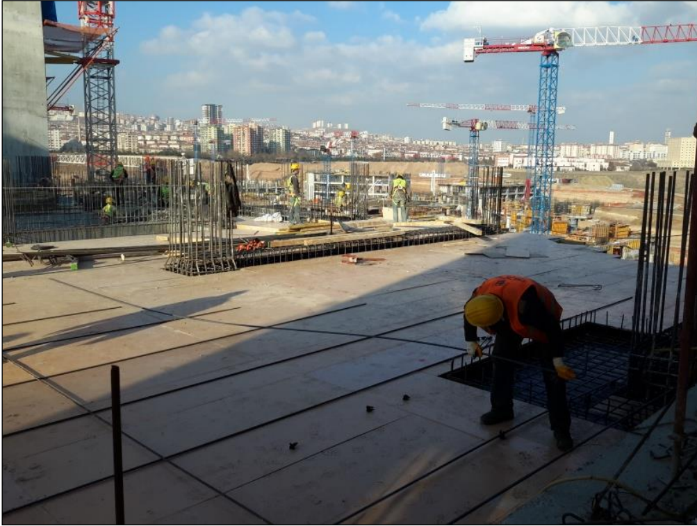
Resim 4.9. Kat döşeme beton atılması öncesi hazırlık işleri
