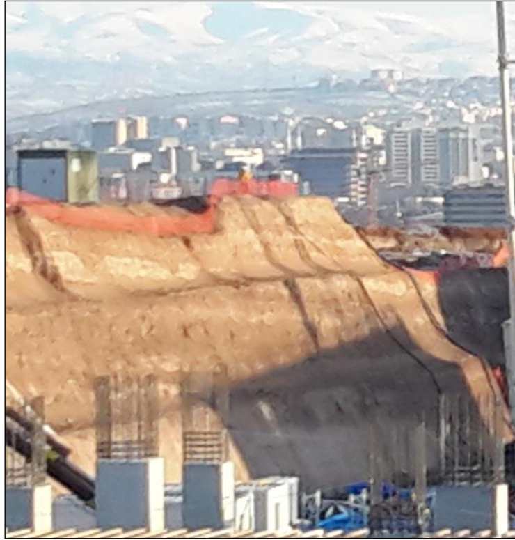
Resim 4.6. Emniyet alan perdesi ile üst kottan yaklaşımın kısıtlanması-1
