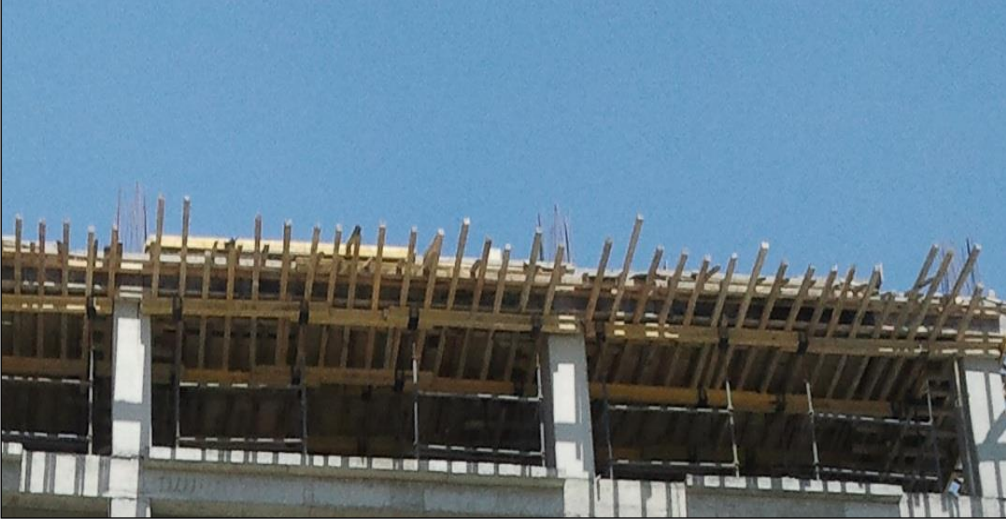
Resim 4.12. Yksekte alıřmada alınmayan nlemler-2
