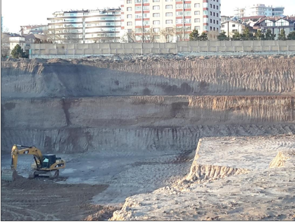
Resim 4.5. Kazı işinde kademeli çalışma ve kazı duvarına bitişik yapılaşma
