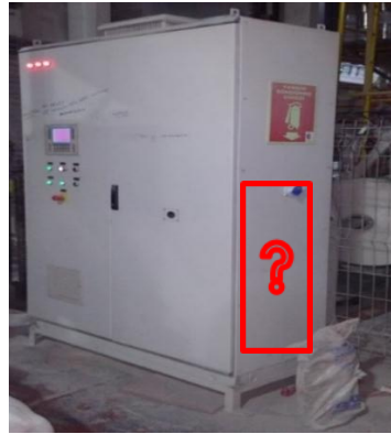
Resim 4.9. Kullanıma hazır olmayan yangın tüpleri
