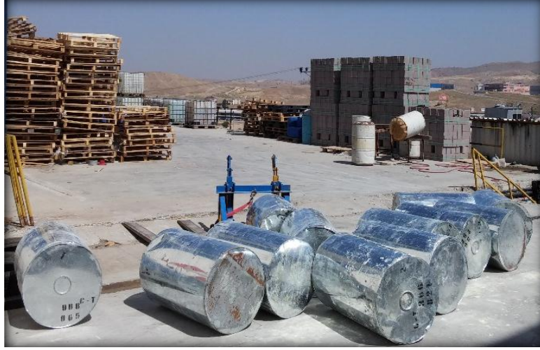
Resim 4.4. Açık alanda gelişigüzel istiflenen malzemeler
