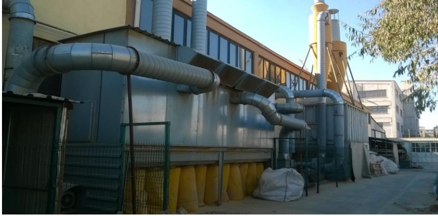
Resim 4.2. B İşyeri Toz Toplama Sistemi
