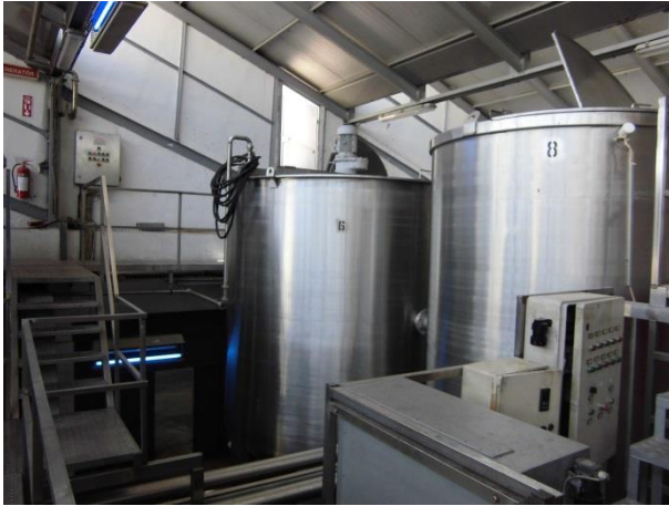
Resim 2.30. Yeterli Doğal Aydınlatma
