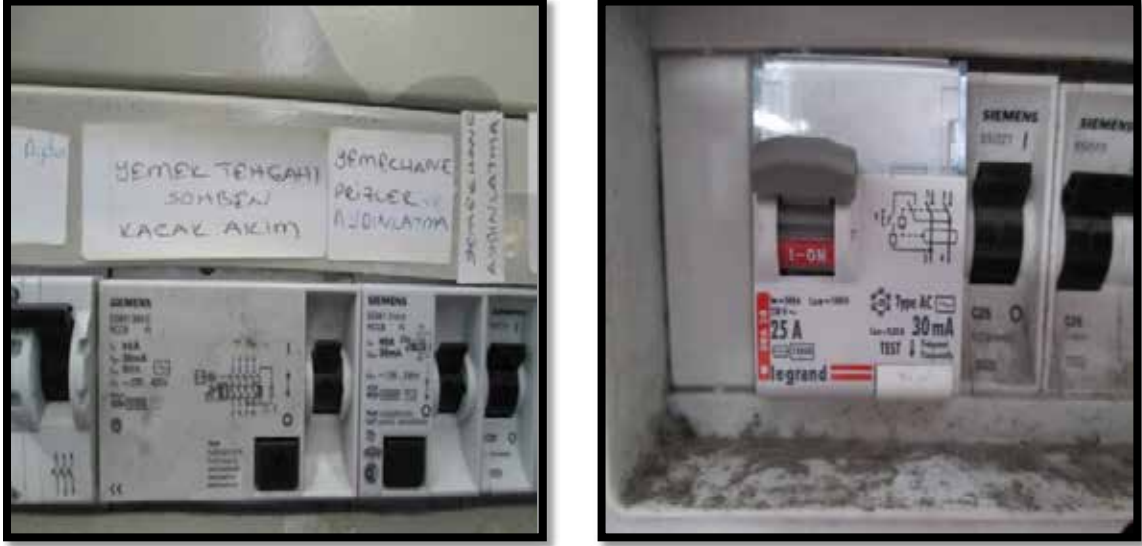
Şekil 4.6 - Teftişlerden sonra kaçak akım rölesi konusunda işyerlerinde yapılan düzenlemeleri gösteren fotoğraflar
