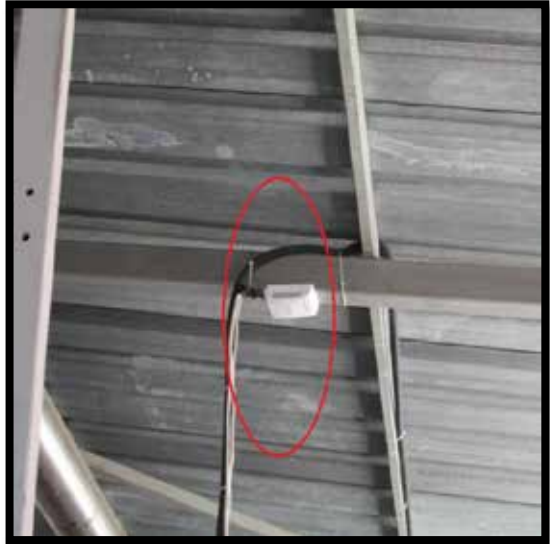
Şekil 4.14 - Doğalgaz dedektörleri konusunda işyerlerinde yapılan düzenlemeleri gösteren fotoğraflar
