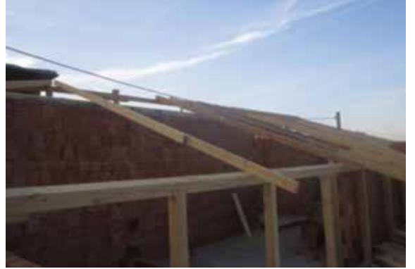
Resim 24. Teftiş Sonrası Çatı Çalışmaları
