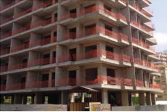
Resim 3. Platform kenarları-Teftiş sonrası
