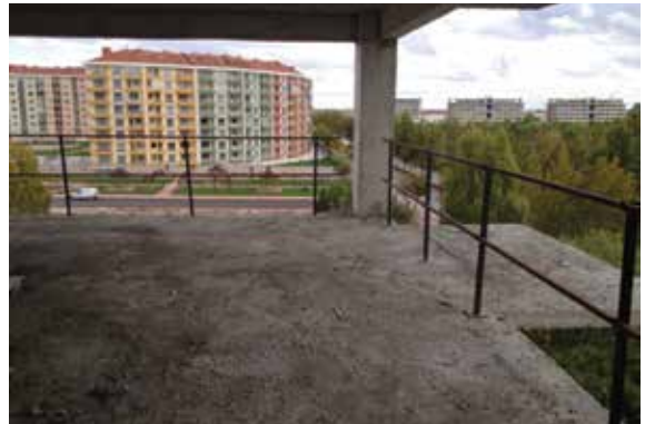
Resim 6. Platform kenarları-Teftiş sonrası
