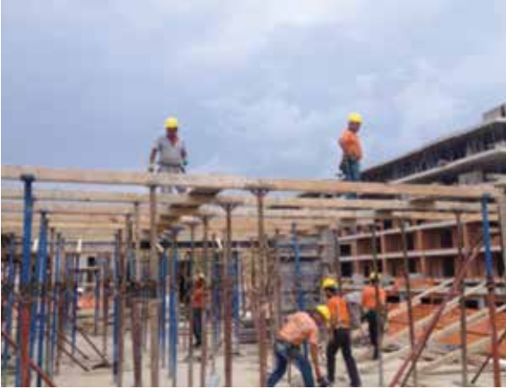
Resim 18. Teftiş Öncesi Kalıp Çalışmaları
