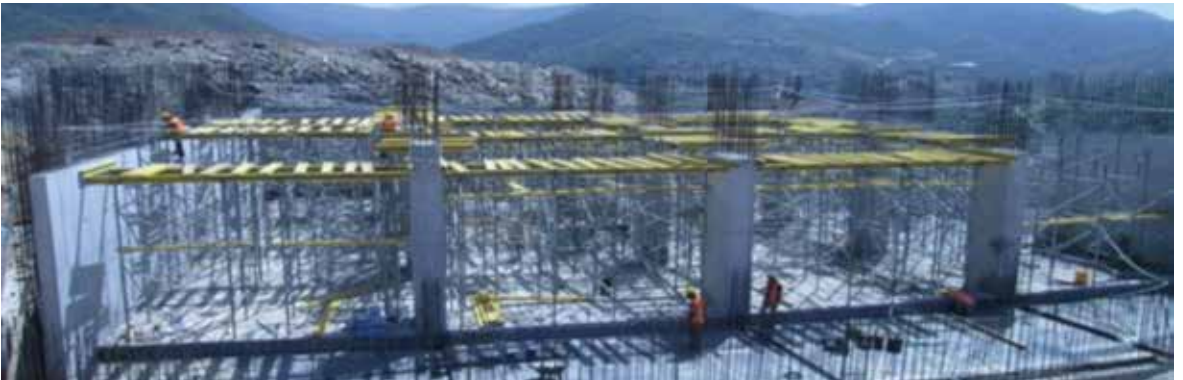
Resim 20. Teftiş Sonrası Kalıp Çalışmaları
