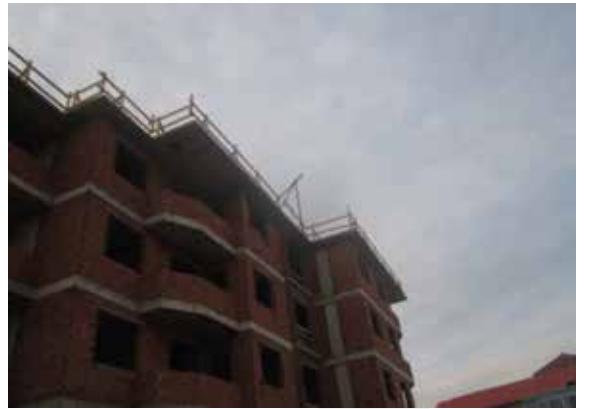
Resim 25. Teftiş Sonrası Çatı Çalışmaları
