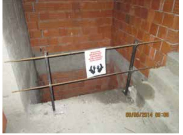
Resim 11. Teftiş Sonrası Asansör Boşlukları
