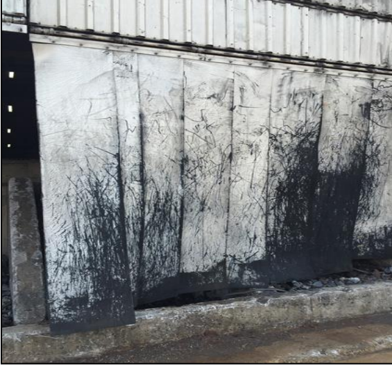
Resim A1 Dışarıdan toz girişini engellemek için kullanılan ayırıcı (plastik perde)
