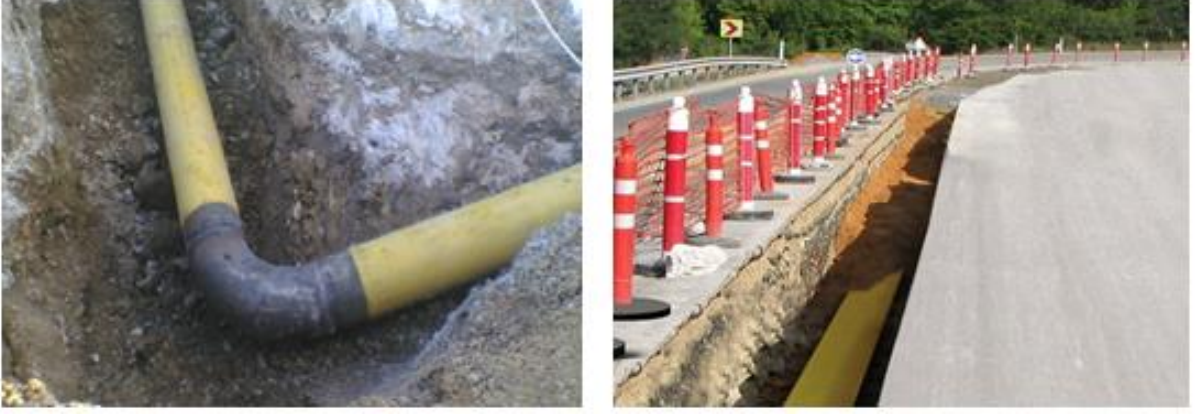
Resim 4.3. Çelik ve polietilen doğal gaz boru montajı işlemleri
