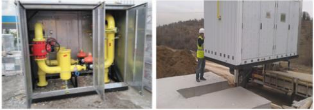
Resim 4.4. RMS-C tipi istasyon montajı
