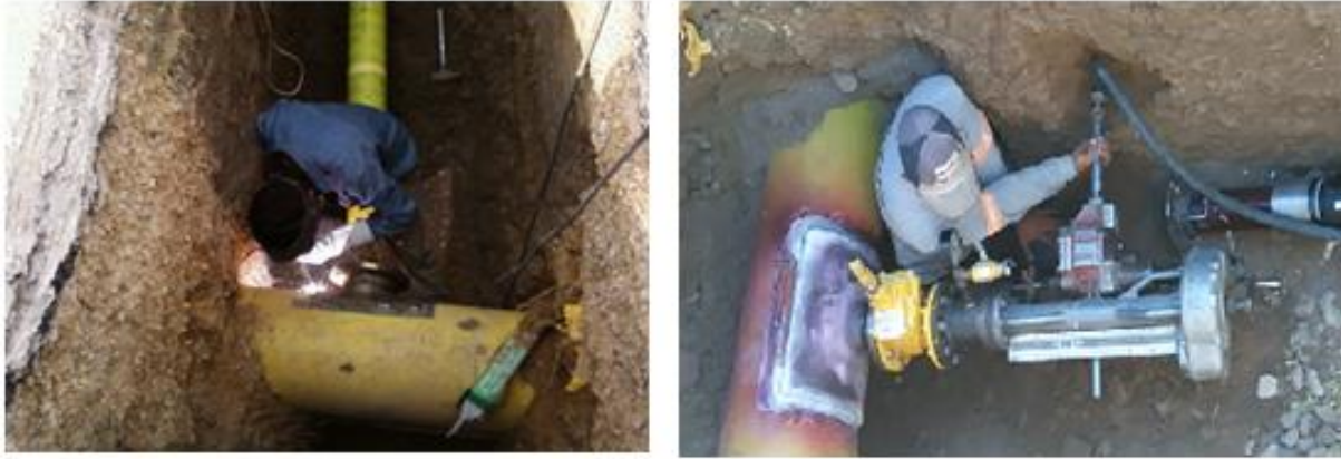
Resim 4.2. Hot-tap operasyonu kaynak ve delme işlemleri
