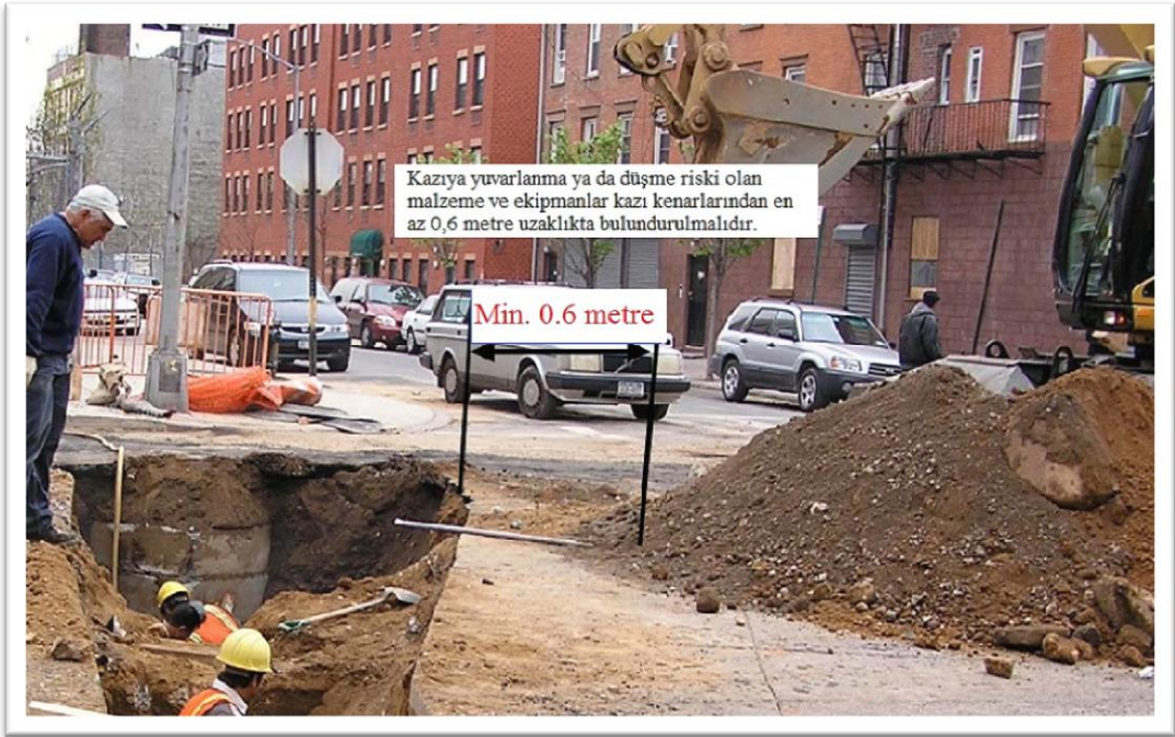
Şekil 6. Hafriyat yığı dar kesitli kazıdan yeterli uzaklıkta tutulmalıdır [10]
