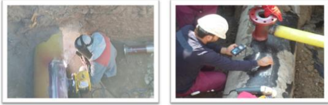
Resim 2.1. Semer kaynağı – ultrasonik boru et kalınlığı testi
