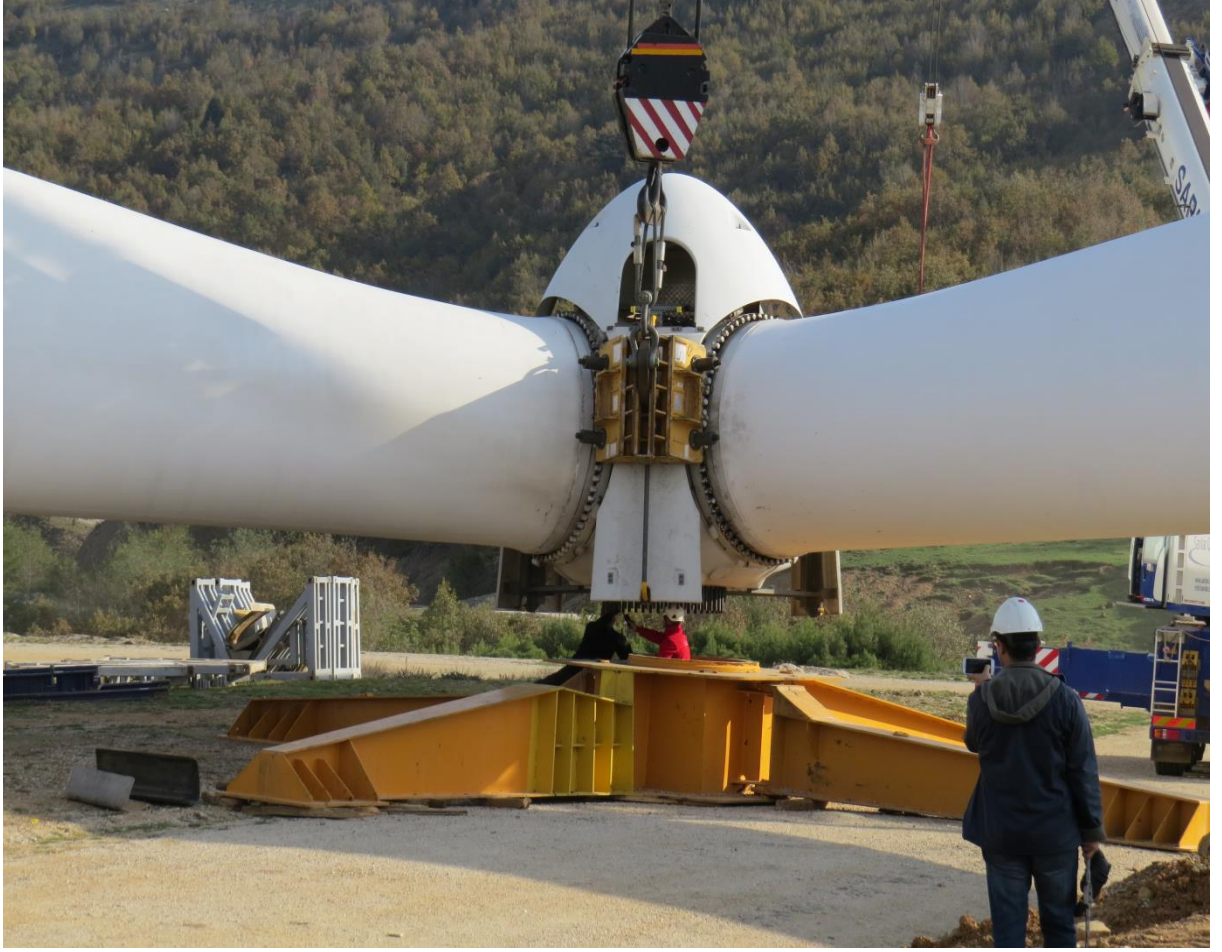
Şekil 2.14. Türbin kanatlarının montajı
