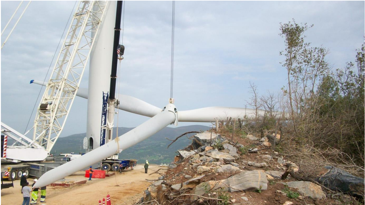
Şekil 2.11. Türbin rotorunun nacelle'ye kaldırılması
