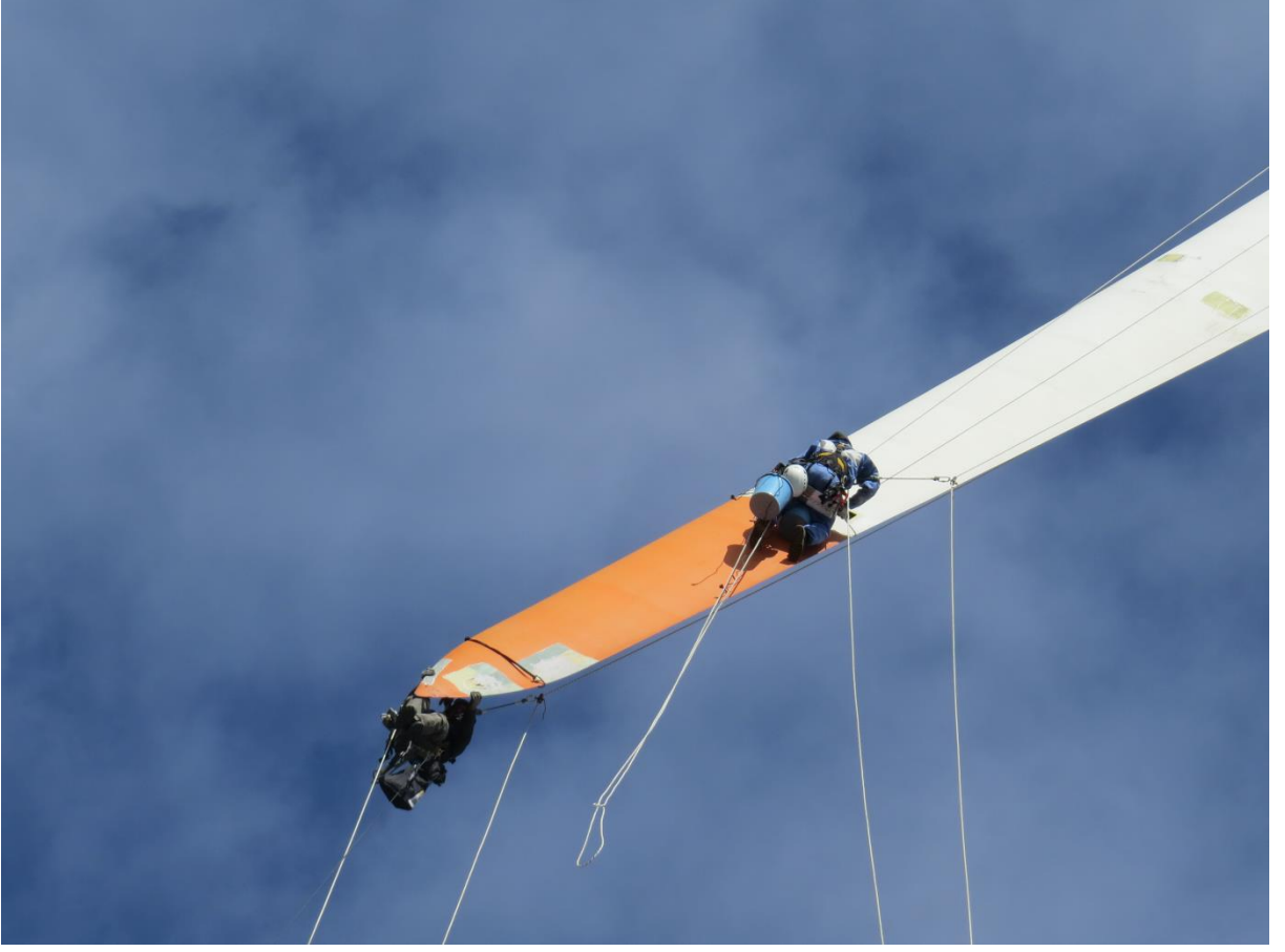
Şekil 2.19. Kanat üzerinde yapılan bir bakım çalışması
