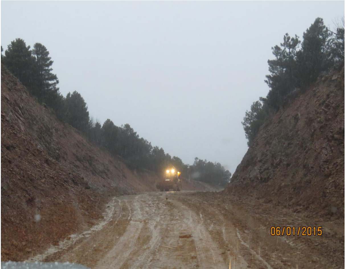
Şekil 2.13. Türbin sahasına ulaşım yollarının açılması
