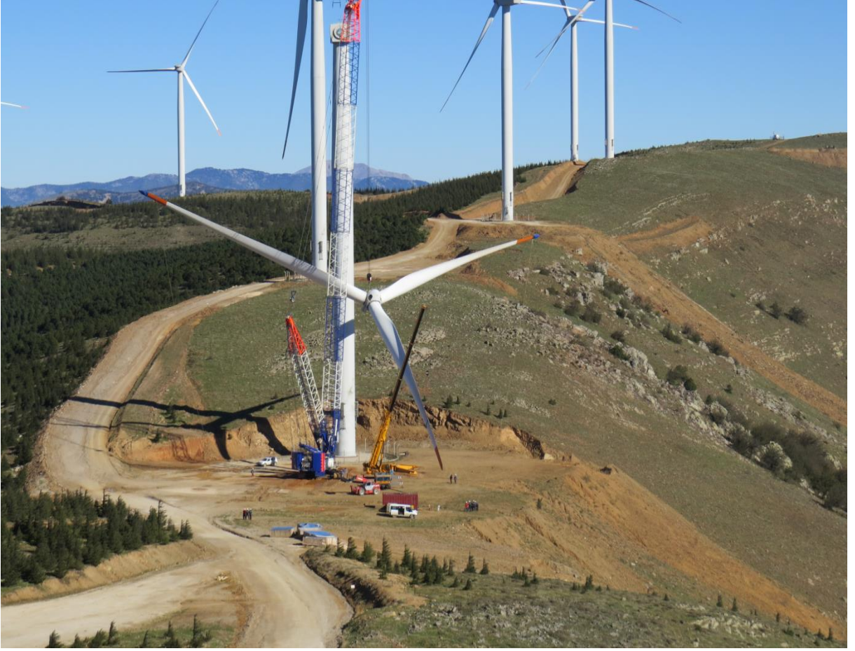
Şekil 2.12. Türbin rotorunun nacelle'ye kaldırılması
