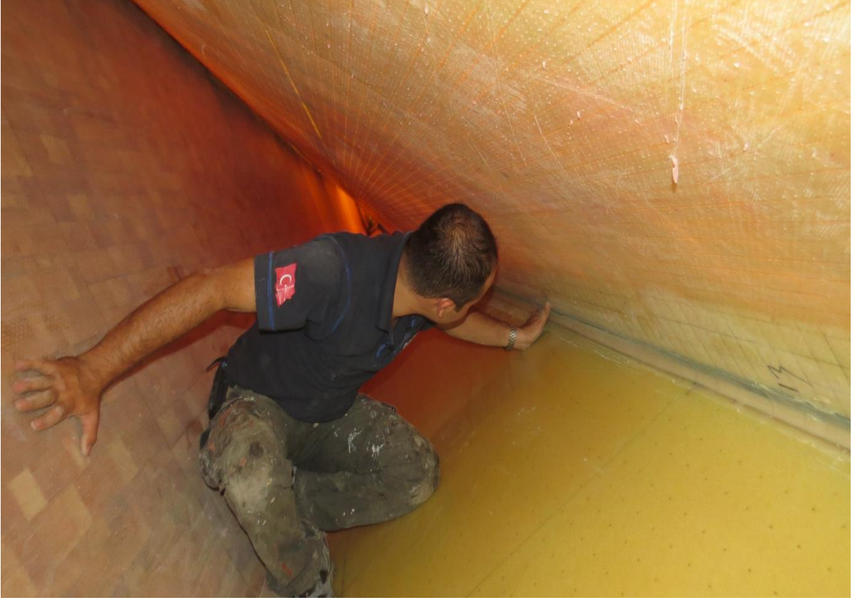
Şekil 2.18. Kanat içerisinde yapılan bir bakım çalışması
