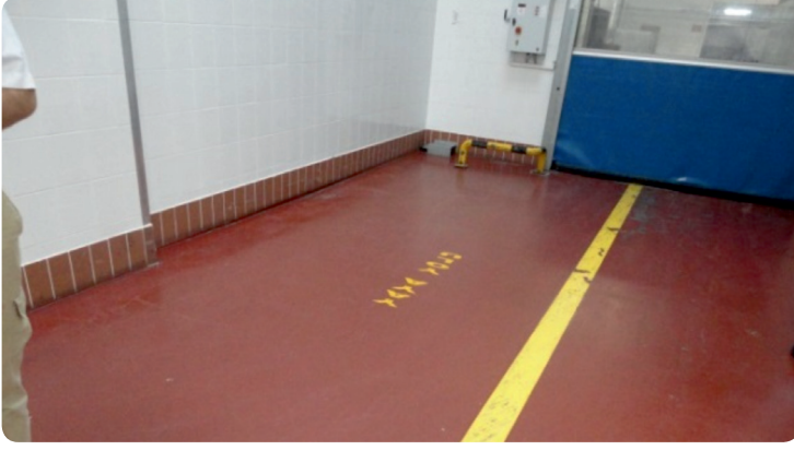
Şekil 9: İyi uygulama örneği: Yaya ve forklift yollarının ayrılması
