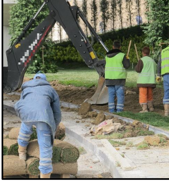
Resim 4.7. Çim serim işlemi öncesi toprağın düzeltilmesi
