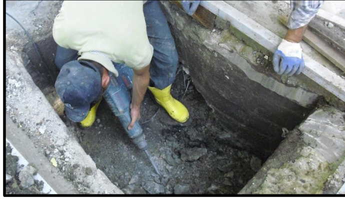
Resim 4.41. Sıhhi tesisat bakım onarımı
