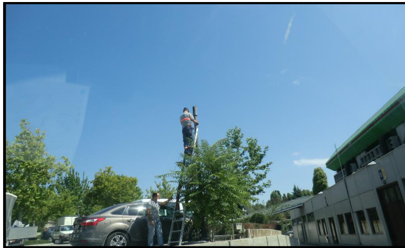
Resim 4.43. Elektrik direği bakım onarımı
