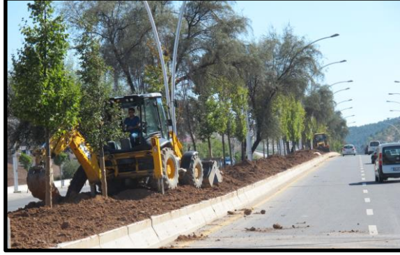
Resim 4.34. Refüjde toprak tesviyesi
