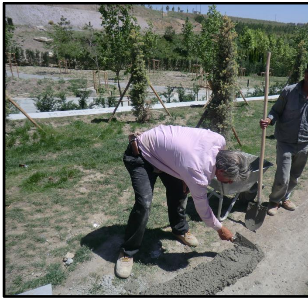
Resim 4.39. Sert zemin işlerinde eğilerek çalışma
