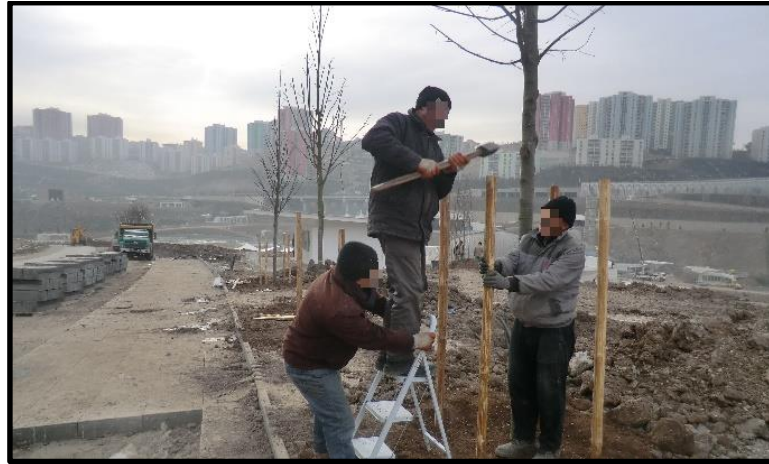
Resim 4.32. Hereklerin çakılması
