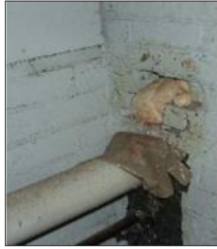
Şekil 11. Açık alanın köpükle kapatılması
