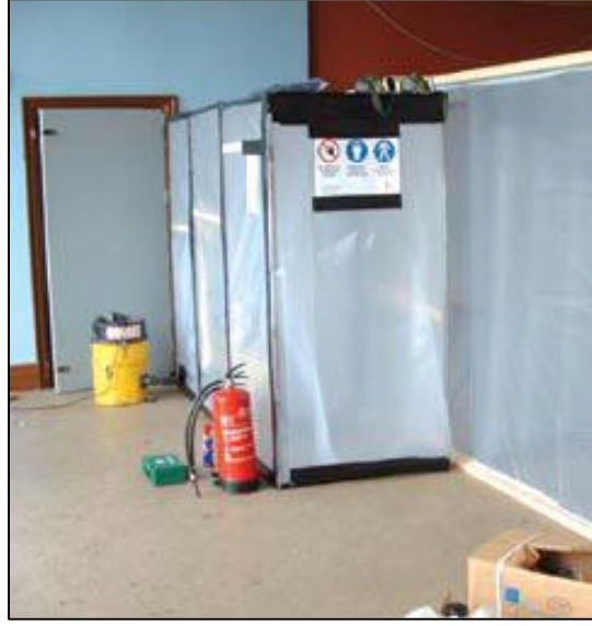
Şekil 17. Geçiş sistemlerinde hava kilitlerinin kullanımı
