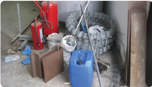
Resim 14. Konum ve erişim yönünden uygun olmayan yangın söndürme ekipmanı
