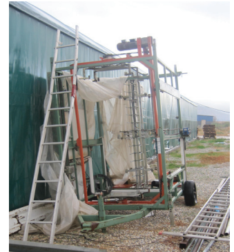
Resim 9. Uygun olmayan el merdiveni kullanımı
