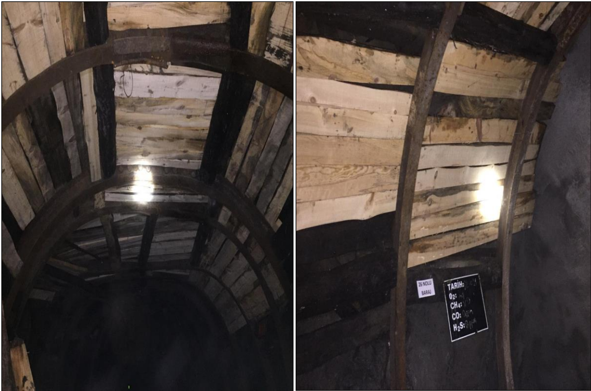
Resim 3.5- Kömür ocağında tahkimat üzerindeki ve yanlarındaki boşluklar doldurularak kamalama uygulaması
