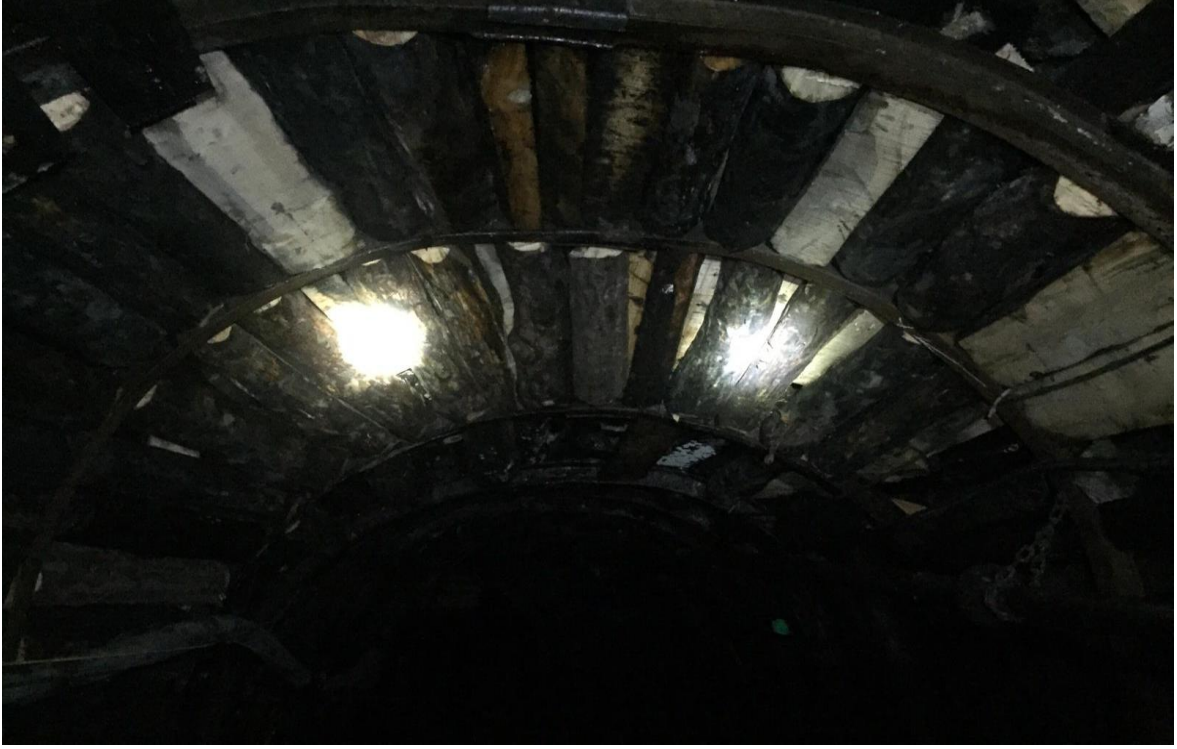
Resim 3.6- Kömür ocağında bağ aralarına fırça uygulaması yapılmıştır.
