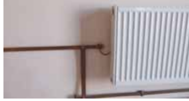
4.42 Statik Yük Topraklaması Topraklaması Yapılmış Radyatör
