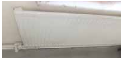
4.41 Toz Birikimini Engelleleyici Radyatör
