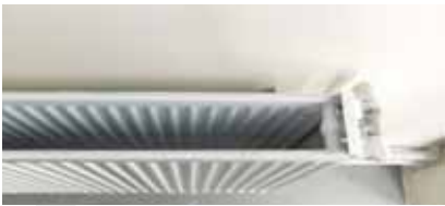
4.40 Toz Birikimine Karşı İçi Boşaltılmış Radyatör
