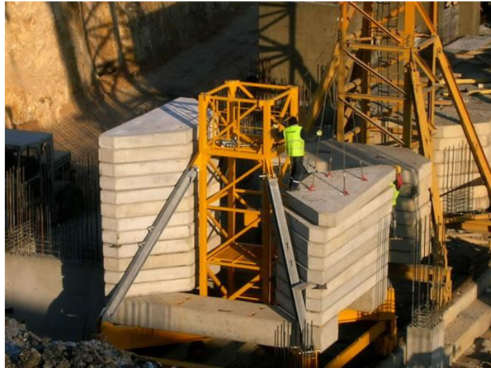
Şekil 30. Taban elemanı ve denge ağırlıklarının yerleştirilmesi
