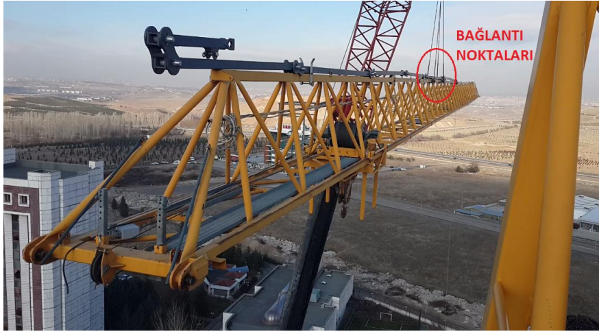
Şekil 43. Mobil vinç tarafından bomun aşağıya indirilmesi
