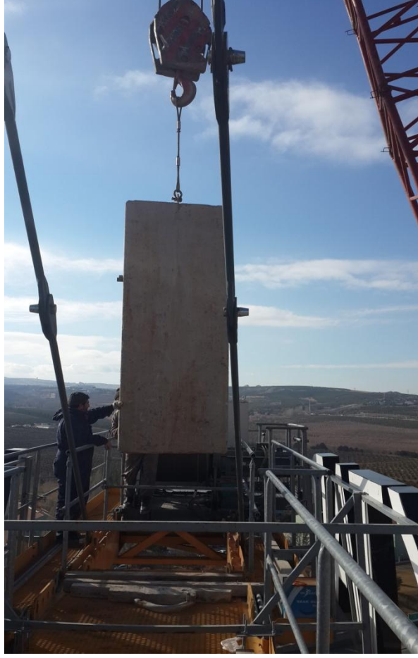
Şekil 33. Kuyruk grubu denge ağırlıklarının yerleştirilmesi
