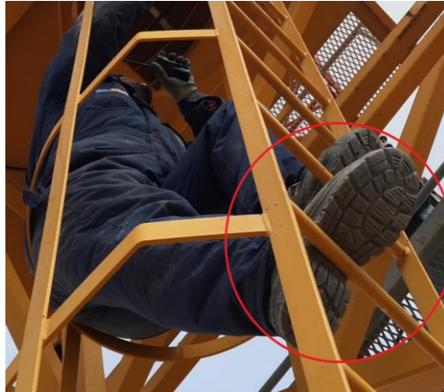
Şekil 36. Ergonomik olmayan merdiven basamağı
