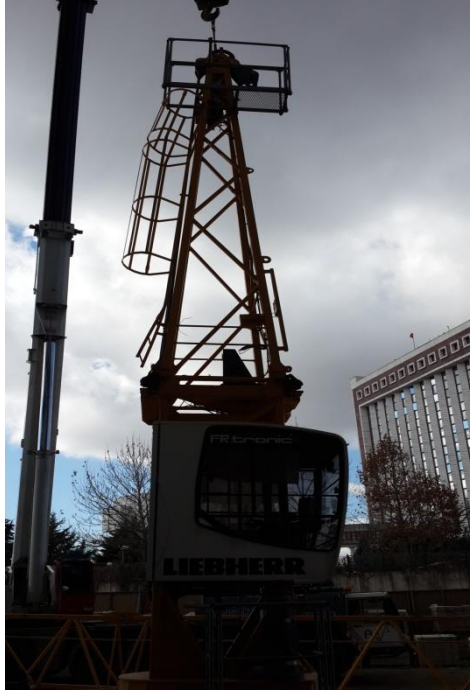
Şekil 44. Kule tepesine çıkış merdiveni
