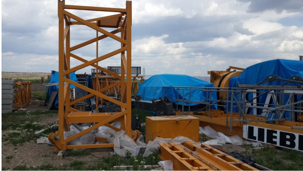
Şekil 47. Kule vinç stoklama sahası
