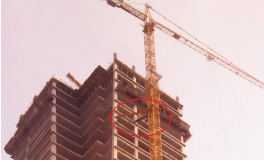
Şekil 37. Vinç-bina geçiş yolu
