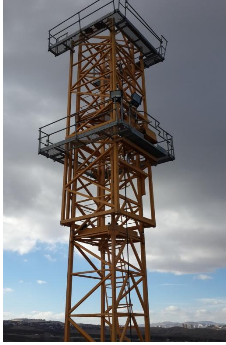
Şekil 45. Bomu, kule tepesi ve kuyruk grubu sökülen kule vinç teleskopu
