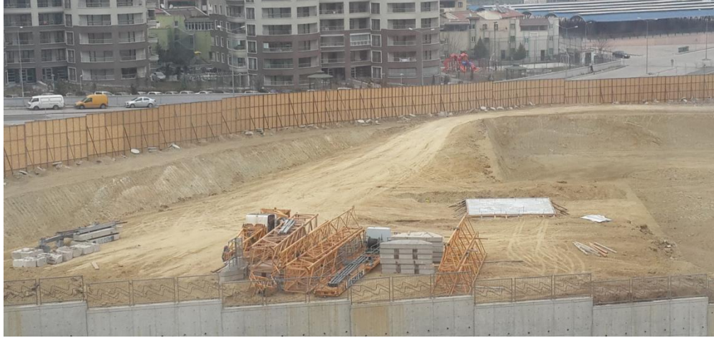
Şekil 29. Kurulum için sahaya getirilmiş kule vinç parçaları
