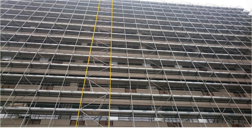
Resim 4.1 İskele içi merdiven
