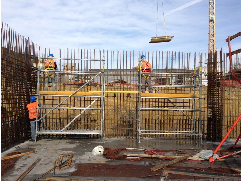
Resim 4.14 Uygun olmayan ekipman kullanımı
