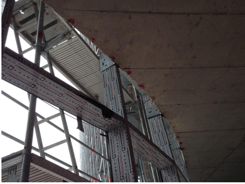
Resim 4.3 İskele-yapı arasındaki mesafe
