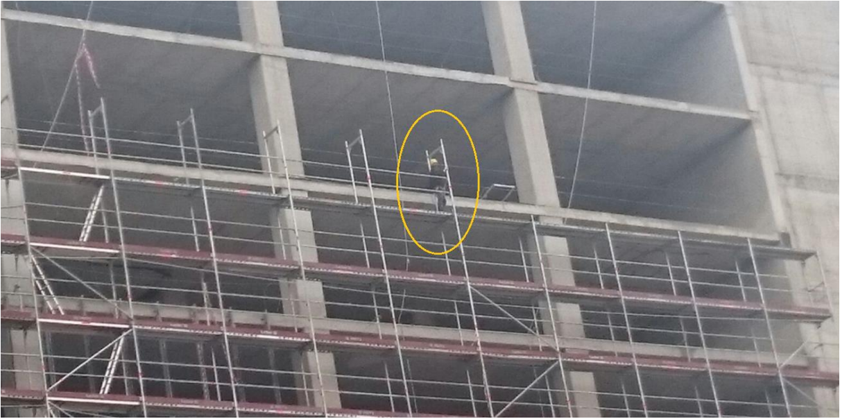
Resim 4.6 Güvenli olmayan çalışma şekli
