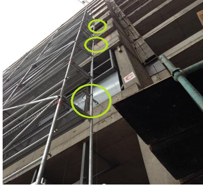
Resim 4.8 İskelenin yapıya ankrajlanması
