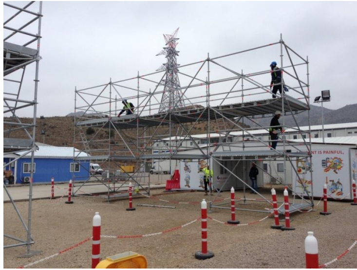
Resim 4.16 İskele çevresinde çalışanların güvenliğinin bariyerler aracılığıyla sağlanması
