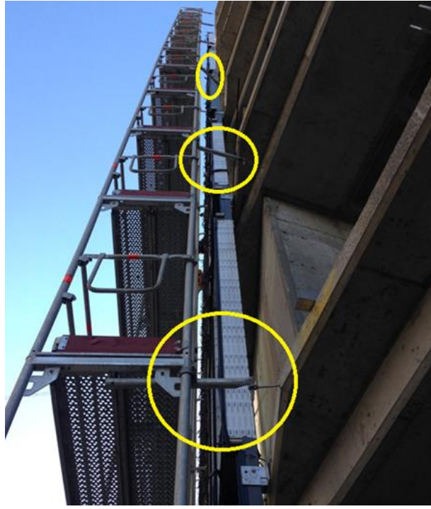
Resim 4.2 Tipik şaşırtmalı bağ paterni şeklinde ankrajlama
