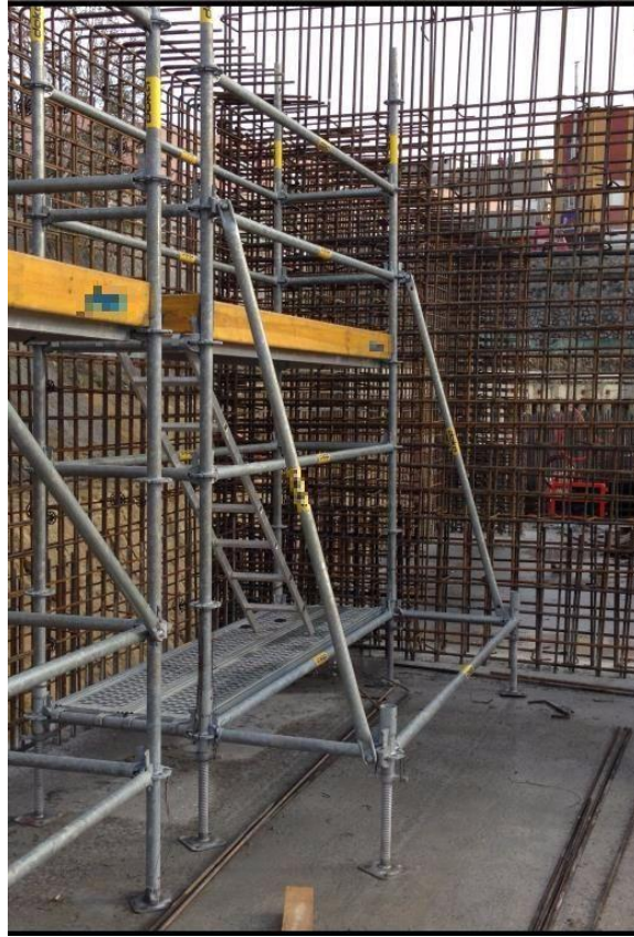
Resim 4.12 İskelenin yapıya ankrajlanmadan yerden destek olarak kullanılması
