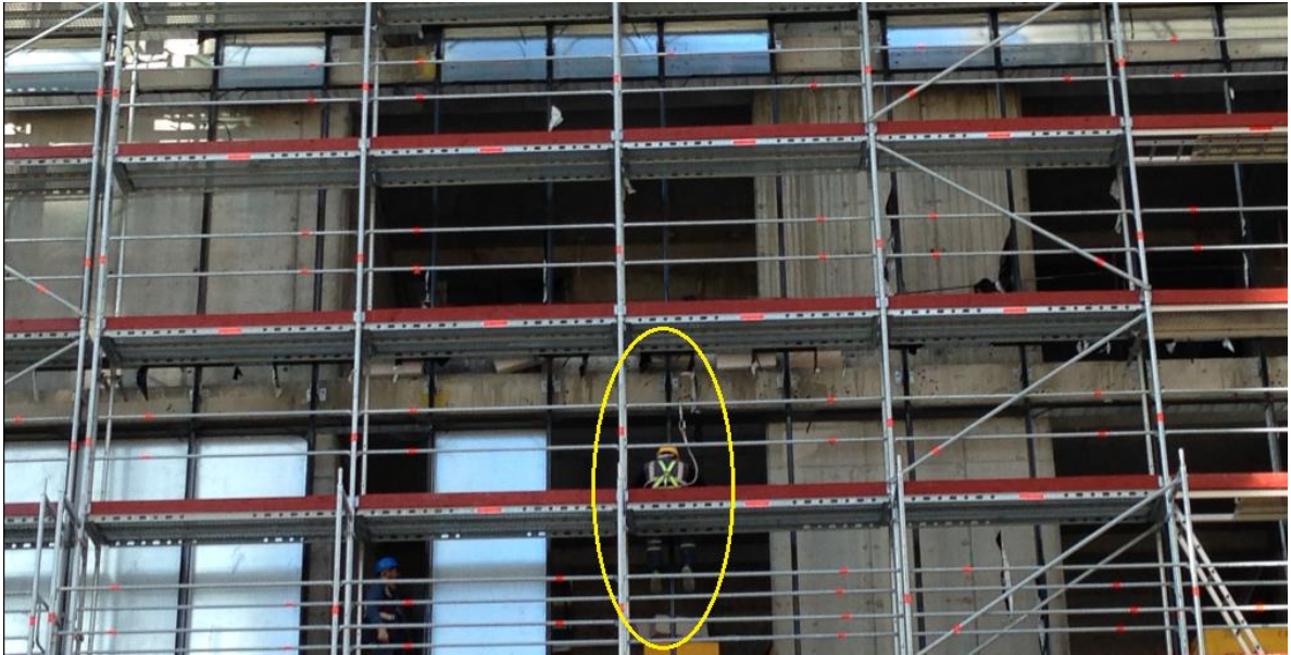
Resim 4.11 Güvenlik ilkelerine uygun olmayan çalışma şekli
