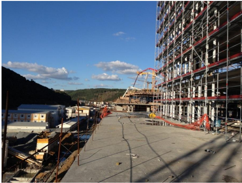
Resim 4.10 İskelede yaklaşmayı önleyici bir bariyer ve işaretleme bulunmaması
