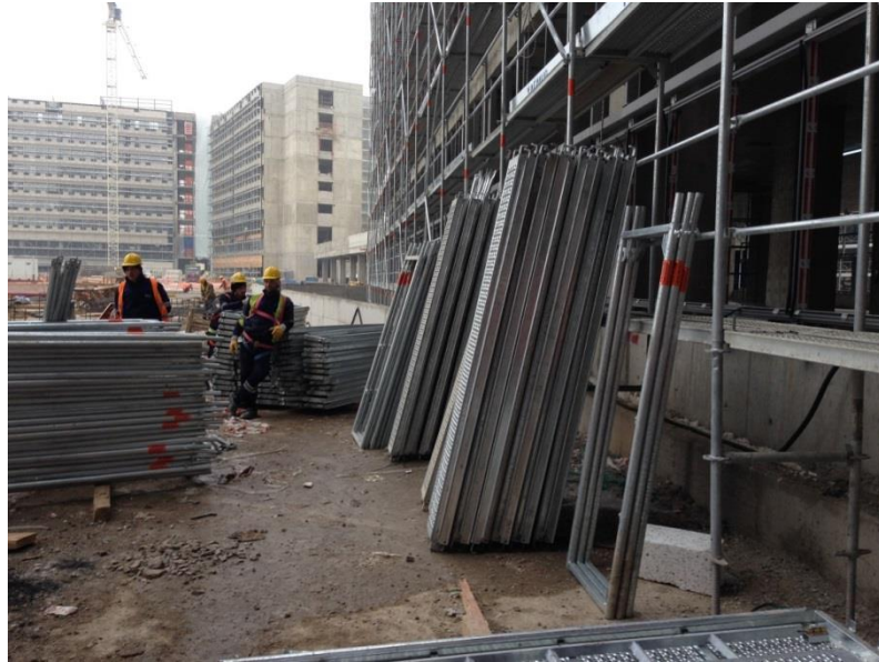
Resim 4.5 İskelenin altında çalışanların bulunması
