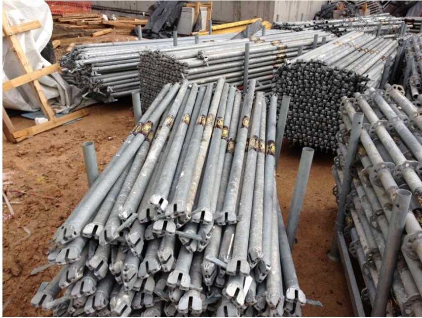
Resim 4.13 İskele yatay bileşenlerinin istiflenmesi
