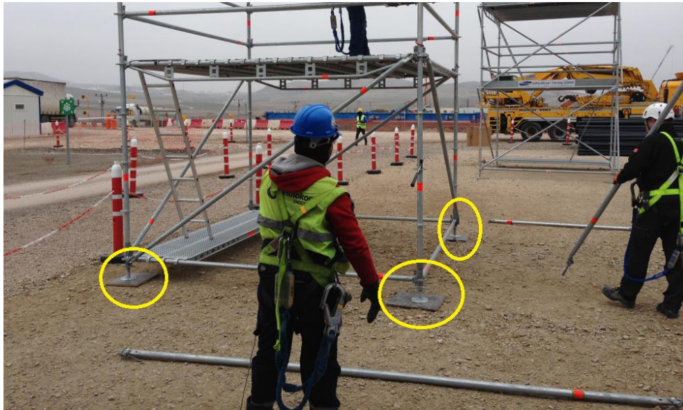
Resim 4.15 Taban plakası ve taban altlığı kullanımı
