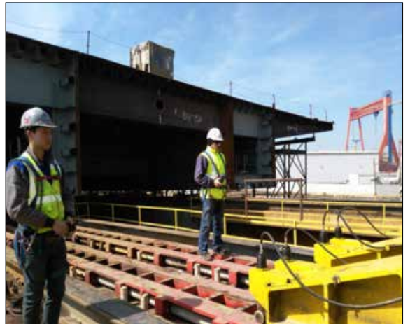
Güney Yaklaşım Viyadüğü Çelik Tabliye Sürme İşlemi
