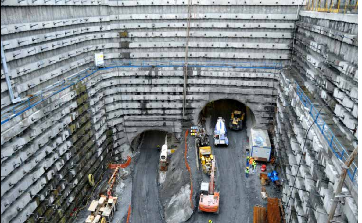
Avrasya Tüneli İnşaatı
