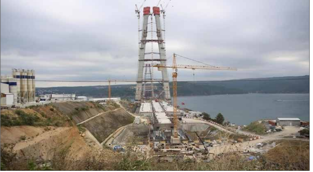
Yavuz Sultan Selim Köprüsü İnşaatı
