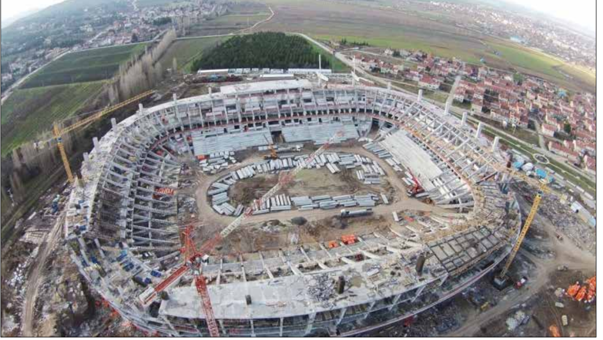
Eskişehir Stadyumu İnşaatı
