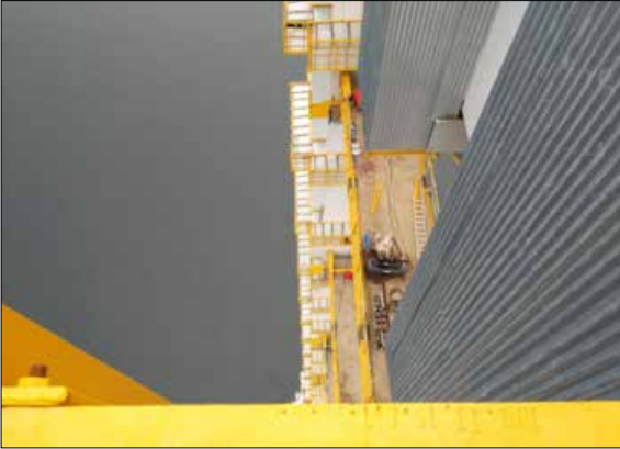
İzmit Körfez Geçiş Köprüsü Kule Ayak
