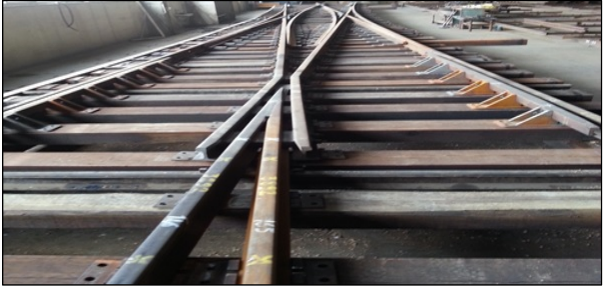
Resim 2.1. Montajı Yapılan Bir Demir Yolu Makası
