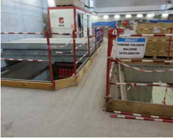
Yürüyüş Yolları ve Merdivenler Üzerinden Kaldırılmış İstifler
