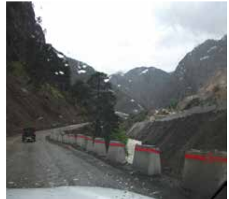
Yol Kenarında Araç Düşmesi Riskine Karşı Alınan Önlemler (Teftiş Sonunda)
