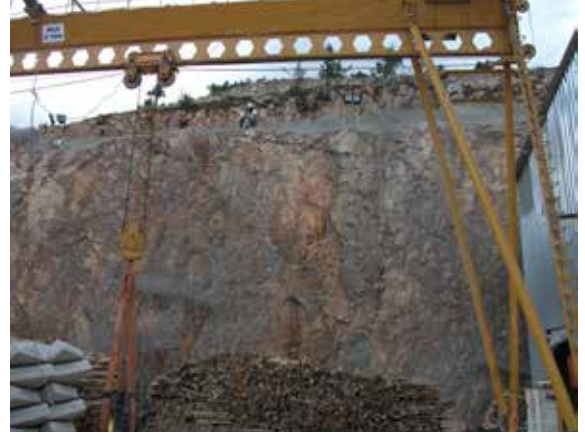
Taş/Kayaç Düşme Riskine Karşı Ağ ile Kaplanmış Şev (Teftiş Sonunda)
