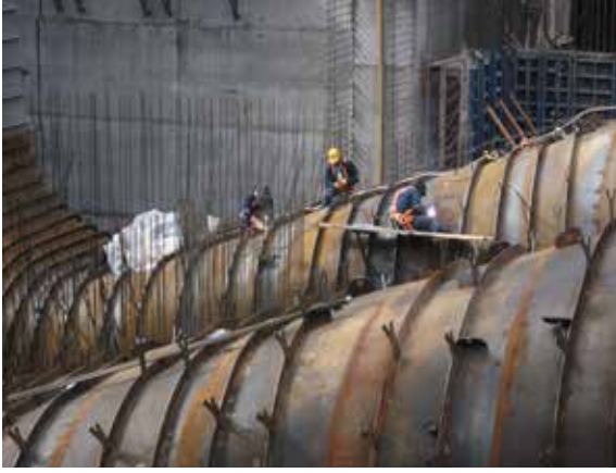
Eğimli Yüzeylerde Çalışma (Teftiş Başlangıcında)
