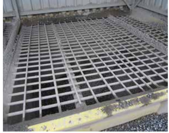
Bunker Ağzında Izgara Sistemleri (Teftiş Sonunda)
