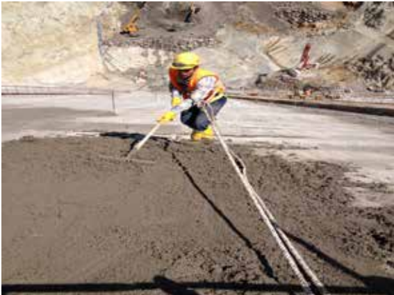
Eğimli Yüzeylerde Kişisel Koruyucular Kullanılarak Yapılan Çalışmalar
