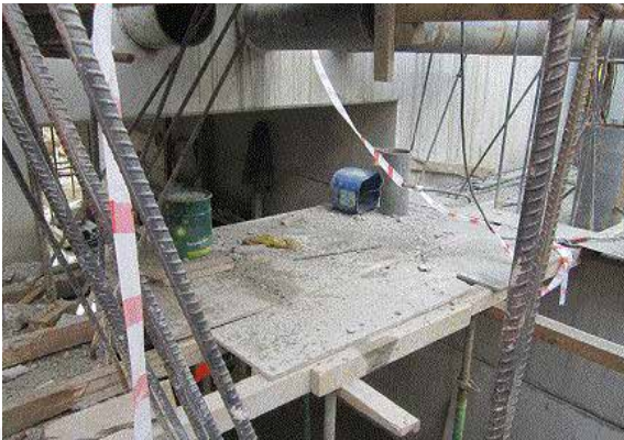
Koruma Önlemi Alınmamış Çalışma İskeleleri (Teftiş Başlangıcında)
