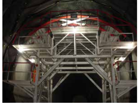
Tünel Kalıp Çalışma İskeleleri (Teftiş Sonunda)
