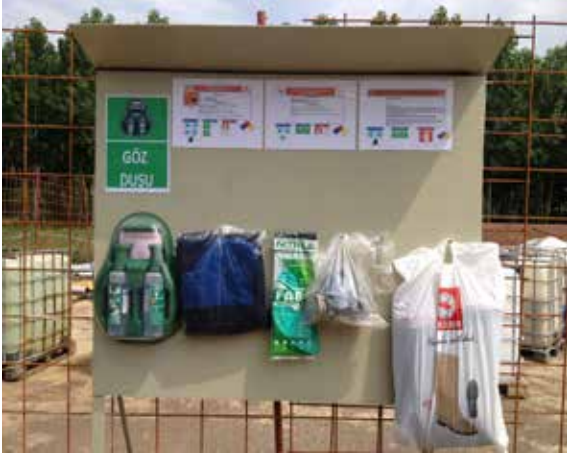
Kimyasal Madde Deposu Yakınında Yüz-Göz Duşları (Teftiş Sonunda)
