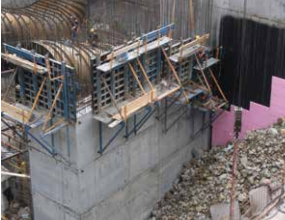
Kalıp İskeleleri (Teftiş Başlangıcında)
