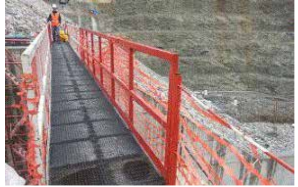
Toplu Koruma Önlemleri Alınmış Geçit
