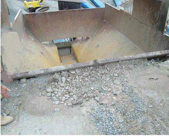
Bunker Ağzında Boşluklar (Teftiş Başlangıcında)
