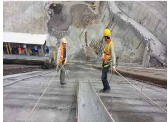
Eğimli Yüzeylerde Kişisel Koruyucular Kullanılarak Yapılan Çalışmalar
