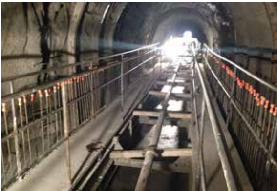
Mantar Şapka Giydirilmiş Donatılar
