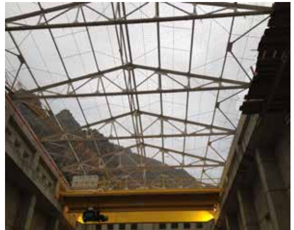
Çatı Konstrüksiyonu Altında Güvenlik Ağları (Teftiş Sonunda)
