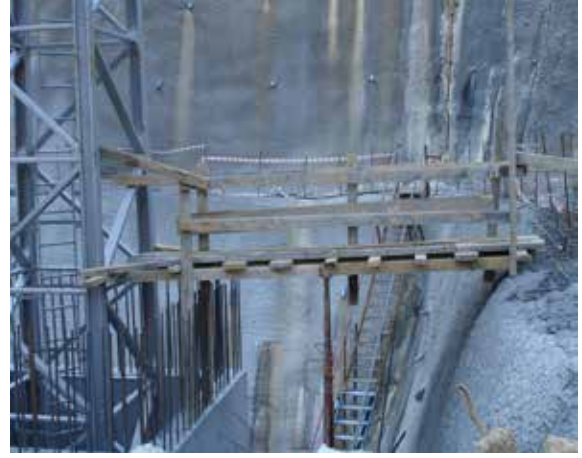
Toplu Koruma Önlemleri Alınmış Geçit
