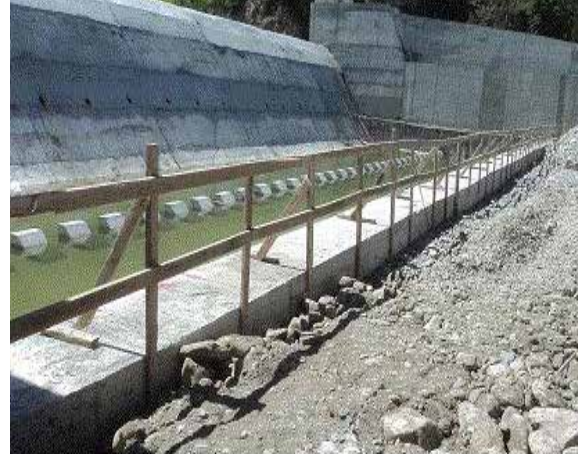
Betonarme Platform Kenarları (Teftiş Sonunda)
