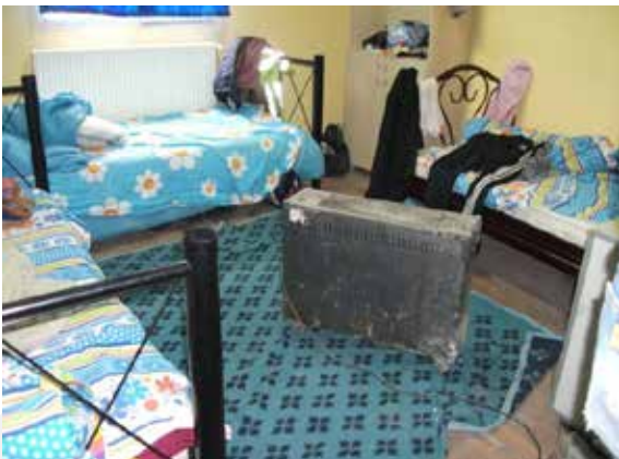
Uygun Olmayan Isıtma Cihazları
