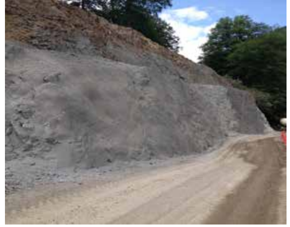
Yüzeyi püskürtme beton ile kaplanmış Yamaç (Teftiş Sonunda)
