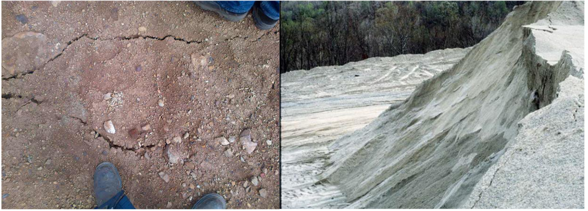
Resim 2.14. Zemindeki çatlaklar ve döküm tabanı altının oyulması [10]
