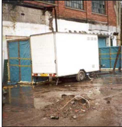
Şekil 9. 10. Hijyen ünitesinin karantina alanına direkt bağlanması
