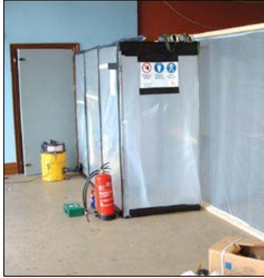
Şekil 9. 9. Geçiş sistemlerinde Airlock'ların kullanımı
