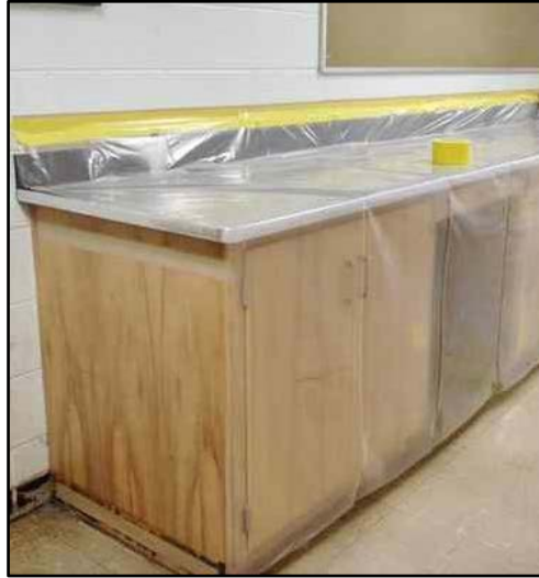
Şekil 9. 16. Taşınmaz malların kaplanması
