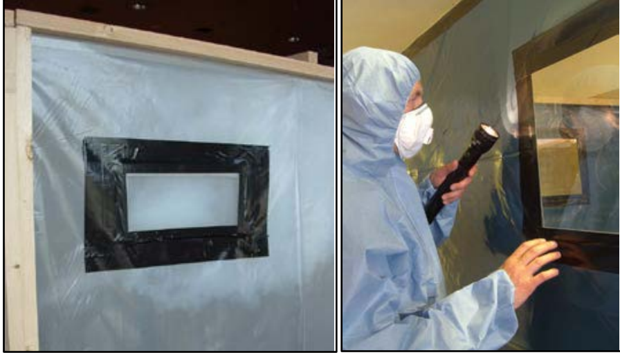
Şekil 9. 17. Duman testi ve duman testi için ışık kontrolü
