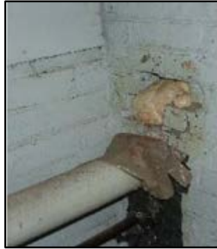
Şekil 9. 3. Açık alanın köpükle kapatılması
