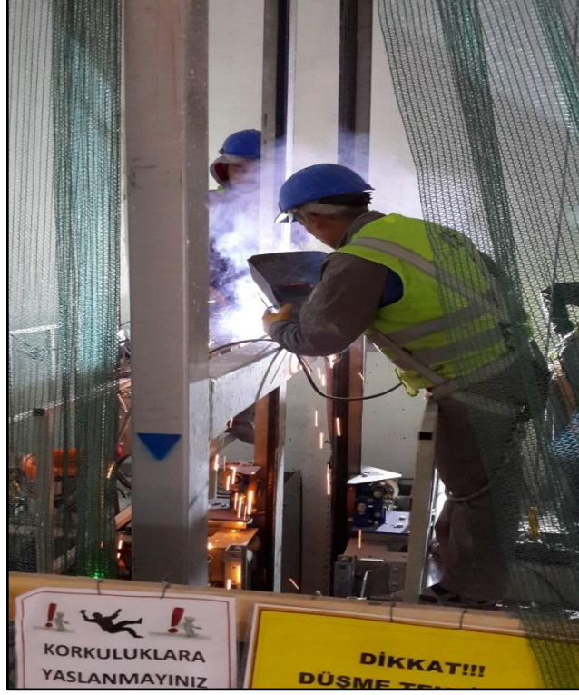
Resim 4.4. Kaynak işleri sırasında oluşan gazlar
