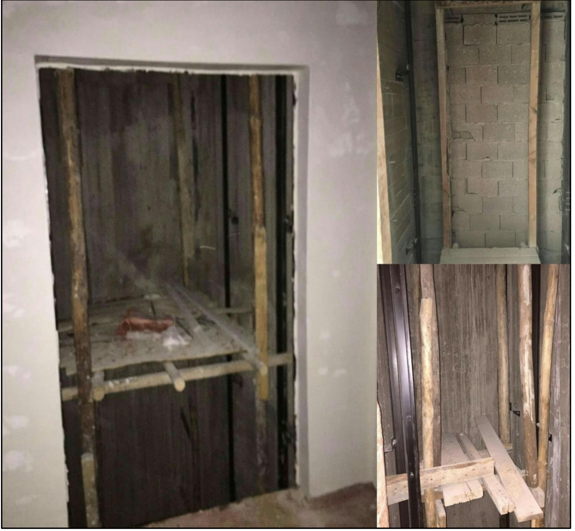
Resim 4.9. Asansör montajı yapılan tahta iskele örnekleri
