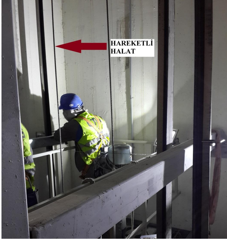
Resim 4.5. Montaj sırasında hareketli halatlar
