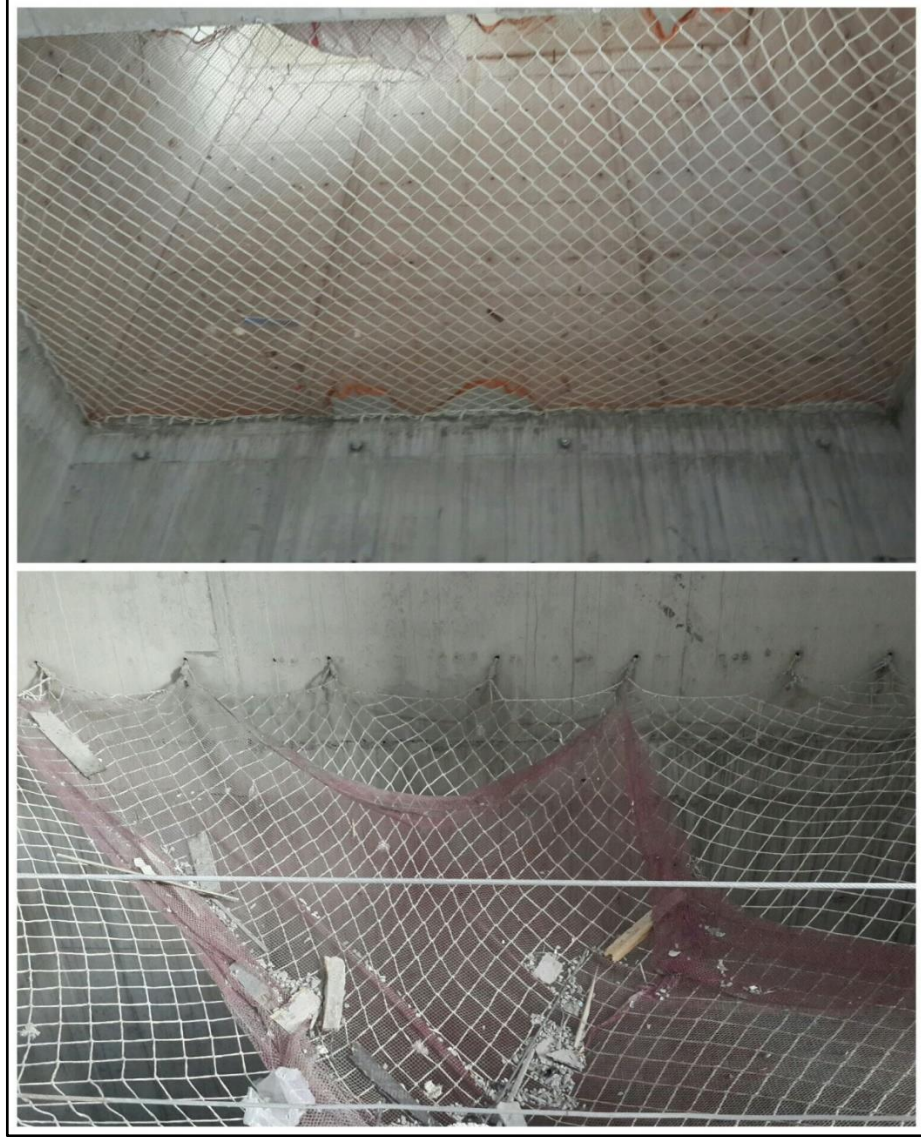
Resim 4.12. Asansör kuyusuna gerilmiş güvenlik ağı
