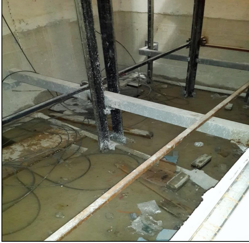
Resim 4.17. Asansör kuyusu dibinde su
