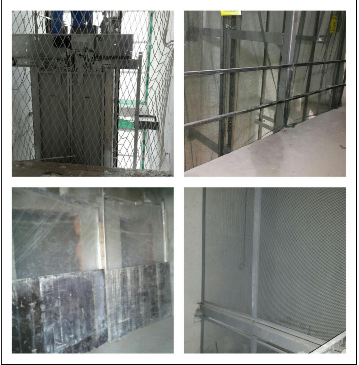
Resim 4.11. Uygun şekilde kapatılmış asansör kuyusu girişleri
