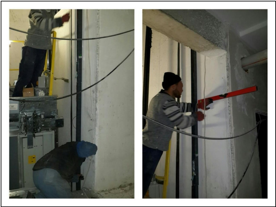
Resim 4.3. Kapı montajı sırasında uygun olmayan postür
