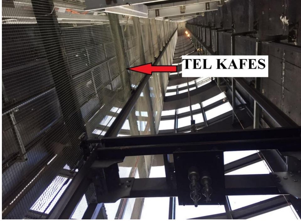
Resim 4.14. Yan yana çalışan iki kabin arasına çekilmiş tel kafes
