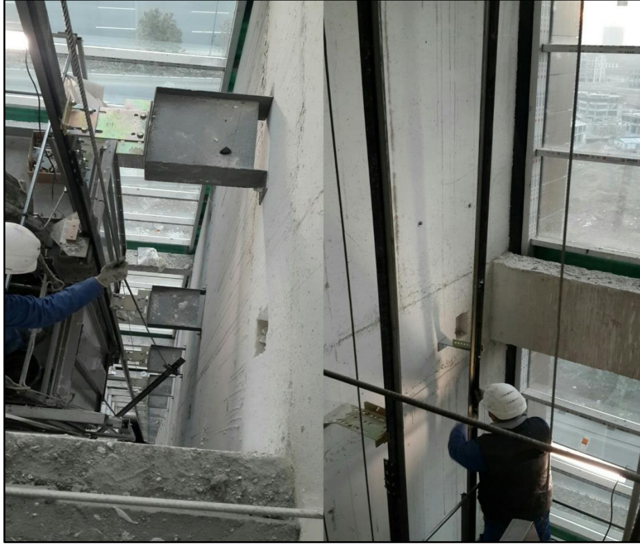
Resim 2.3. Kılavuz ray taşınması ve montajı
