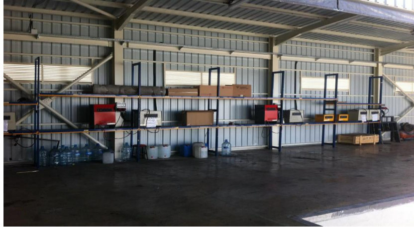
Resim 4.6. Forklift şarj ünitesi
