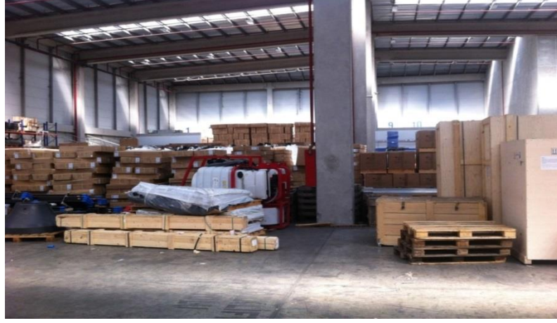
Resim 4.14. Tıkanmış yangın dolabı
