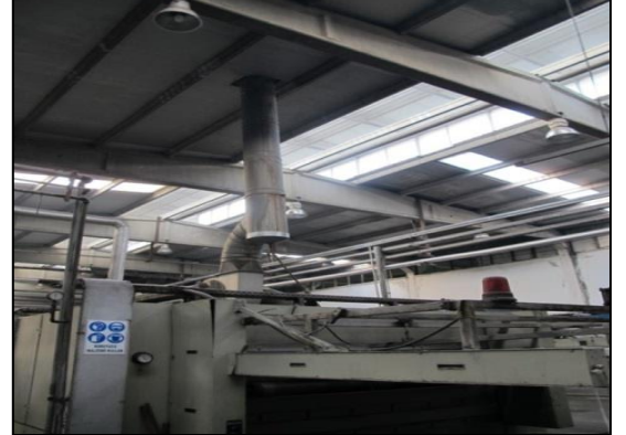
Resim 4.52. Baskı makinesi havalandırma bacası
