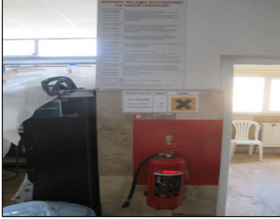
Resim 4.43. Uygun yükseklikte konumlandırılmış yangın söndürme cihazı
