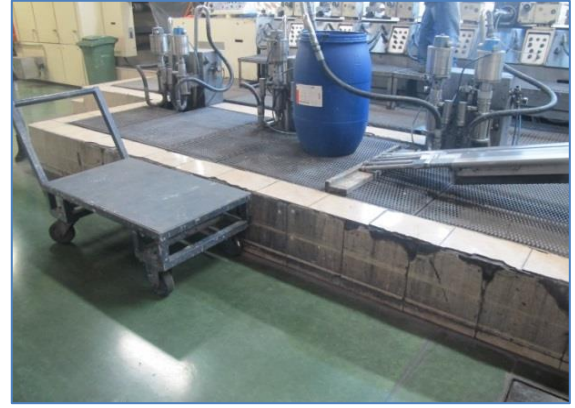
Resim 4.66. Yükseltilmiş çalışma platformuna baskı patı taşıma
