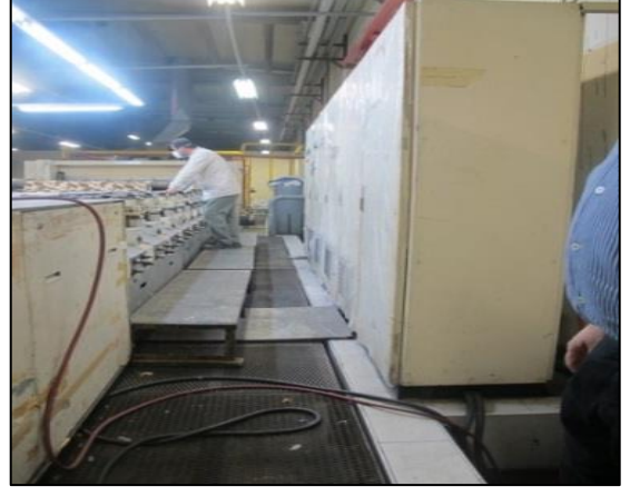
Resim 4.58. Geçiş yolu üzerinde malzeme bulunması
