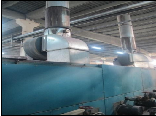
Resim 4.51. Baskı makinesi havalandırma bacası
