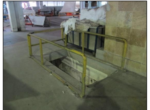
Resim 4.19. İşletme zemininde bulunan korkuluk
