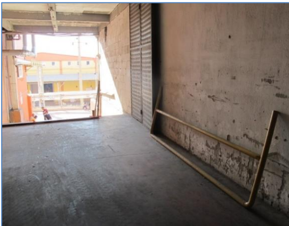
Resim 4.63. Korkuluk bulunan yükleme rampası
