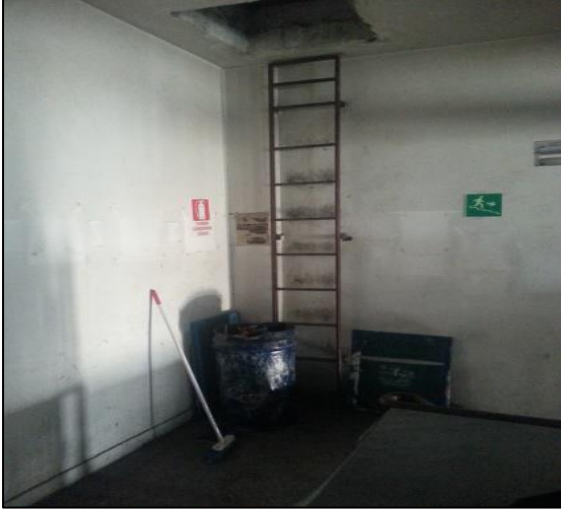
Resim 4.1. Çatıya çıkış için merdiven kullanımı
