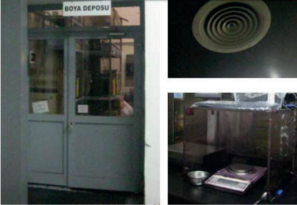
Resim 7. Tozun yayılımını önleme. Tozlu proseslerin diğer proseslerden ayrı odacıklar- da konuşturılarak girişin sınırlandırılması.
