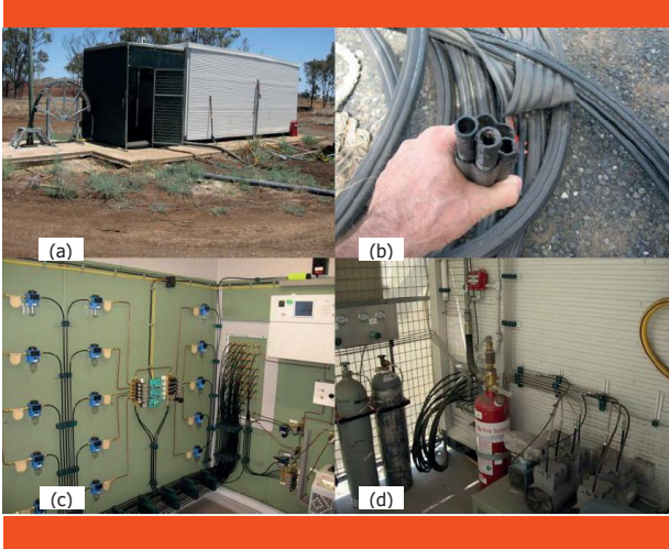
Şekil 5.2 Hortum demeti yönteminin bileşenleri (a) izleme odası, (b) yedili hortum demeti (c) selenoid valf manifoldu sistemi ve (d) vakum pompaları (Brake, 2013).
