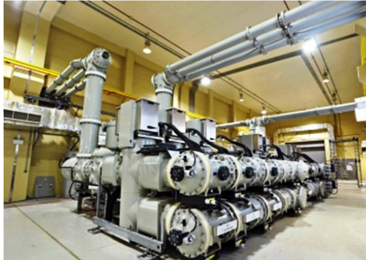
Şekil 2.9: Kapalı Şalt Sistemi (GasInsulated Substation (GIS))
