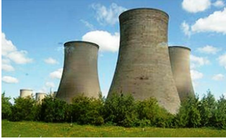
Şekil 2.6: Su Soğutma Kulesi
