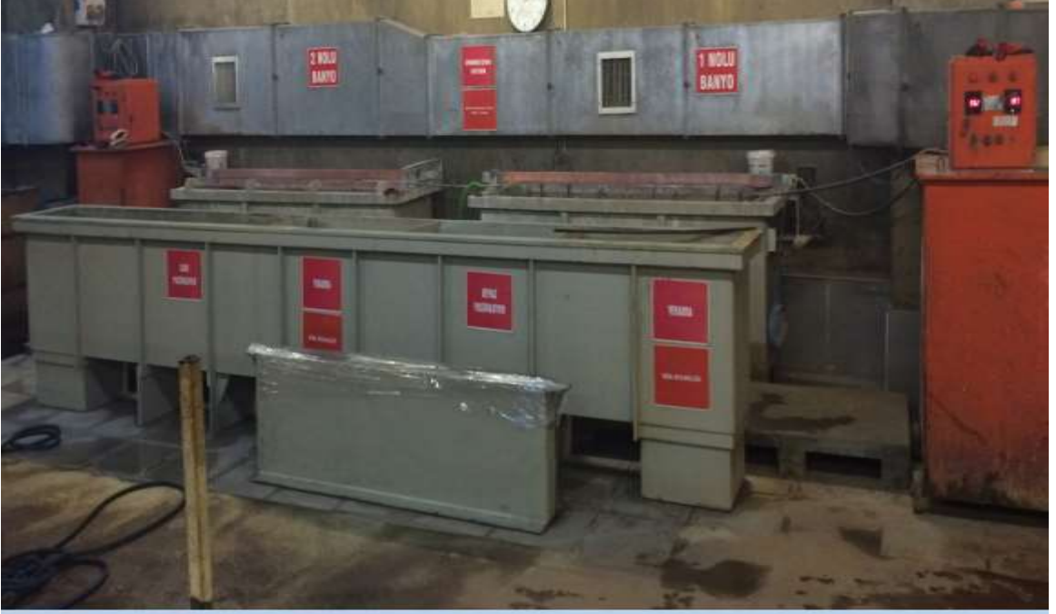
Resim 2.3. Çinko Havuzu, Pasivasyon Havuzu ve Su ile Yıkama Havuzu
