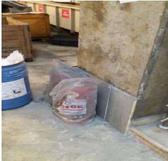
Resim 4.17. Uygun Şekilde Bulundurulmayan Yangın Cihazları
