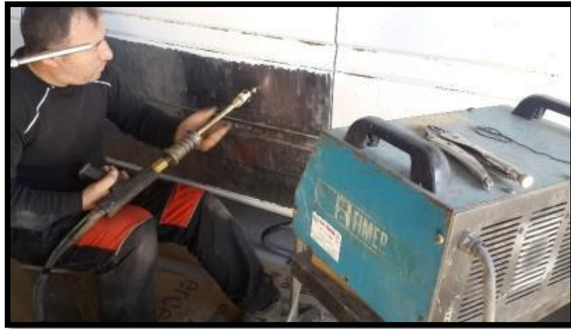
Resim 2.4. Spot hızlı çekirme cihazı ile kaporta düzeltme
