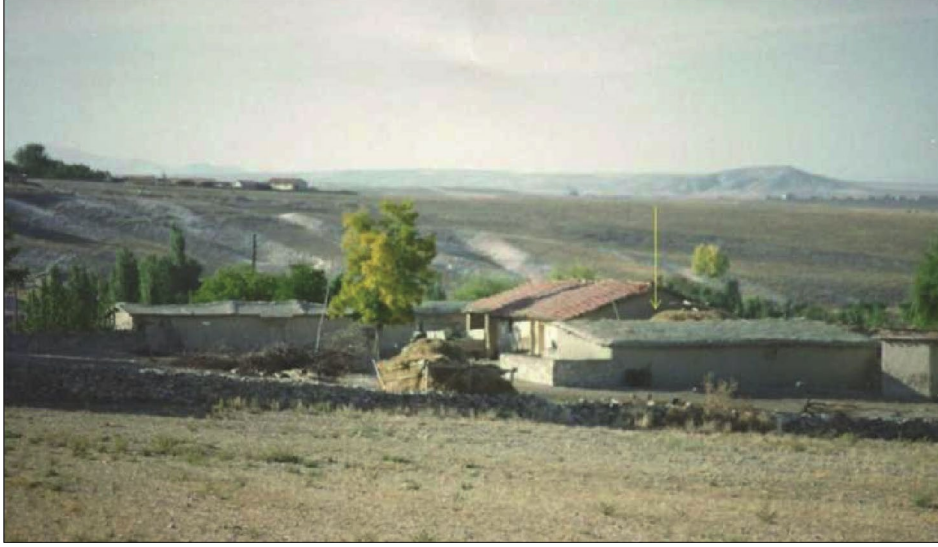
Resim 1. Çatıda ak toprak kaplama
