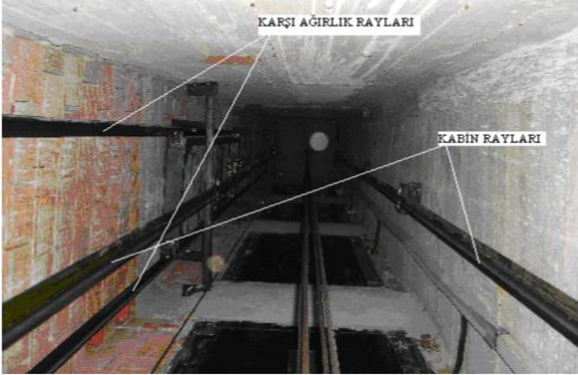
Şekil 1. Asansör kuyusunda kabin ve karşı ağırlık rayları [26]
