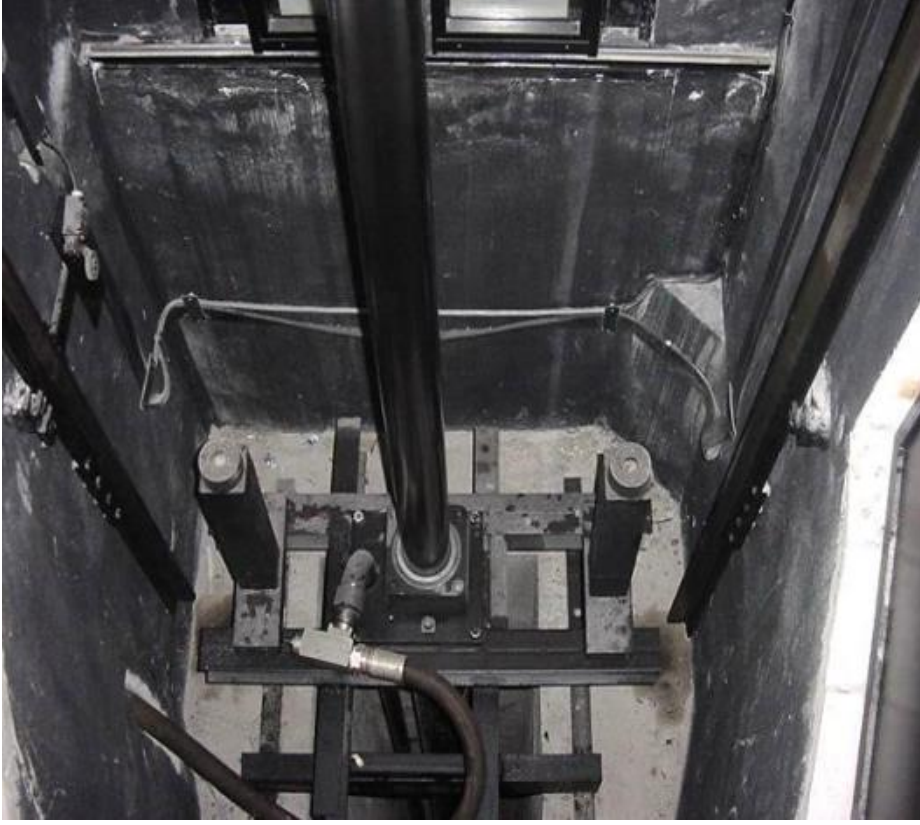
Resim 6. Merkezden tahrikli hidrolik asansör örneđi [29]
