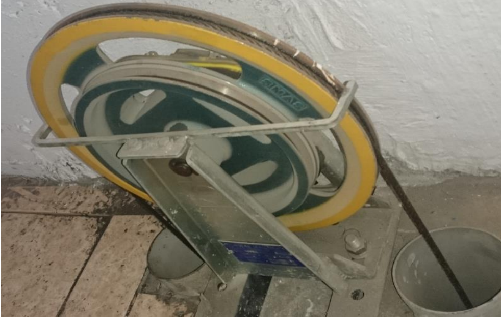
Resim 7. Asansör paraşüt mekanizması örneği
