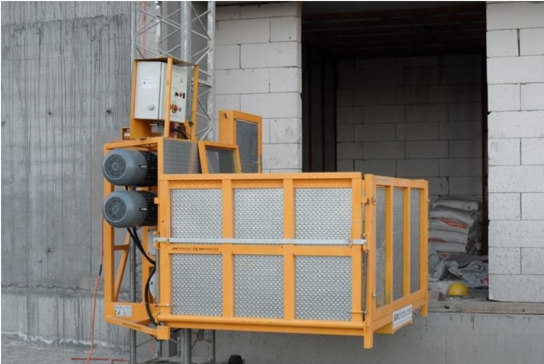
Resim 10. Yalnızca yük taşıyabilen cephe asansörü örneđi
