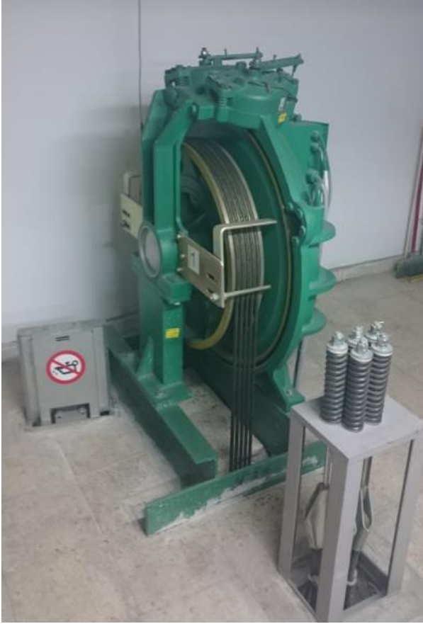
Resim 5. Elektrikli asansör tahrik grubu örneği
