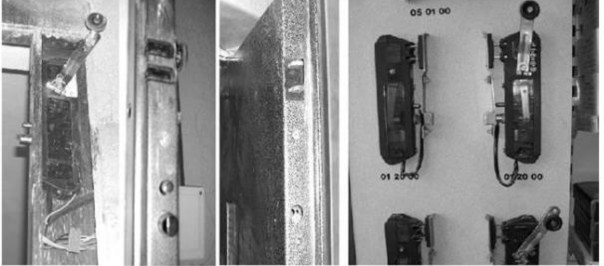
Resim 4. Çift emniyetli kilit ve fiş-priz bağlantısı [28]
