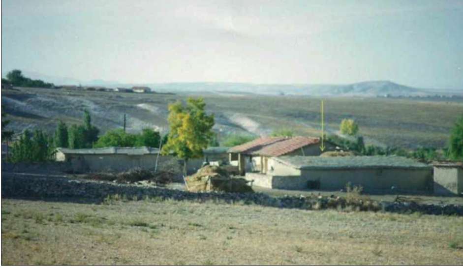
Resim 1. Çatıda ak toprak kaplama
