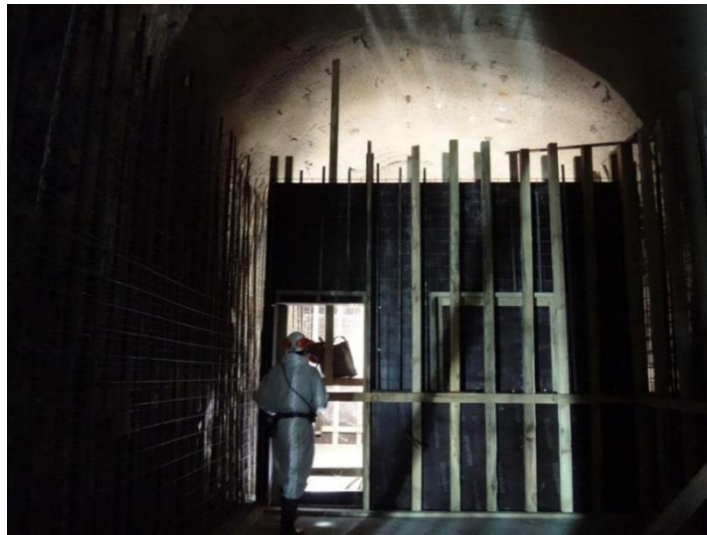
Şekil 4.18. İşletmede yapım aşamasındaki sabit sığınma odası
