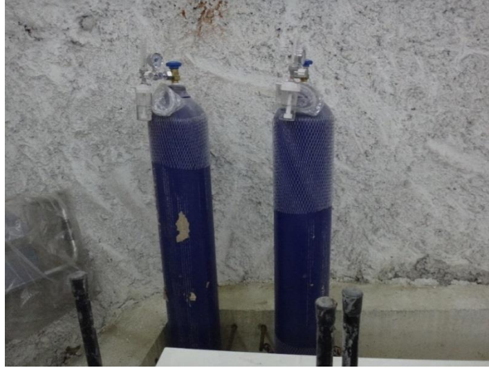
Şekil 4.23. 15 kişi kapasiteli sabit sığınma odasında bulunan O 2 tüpleri
