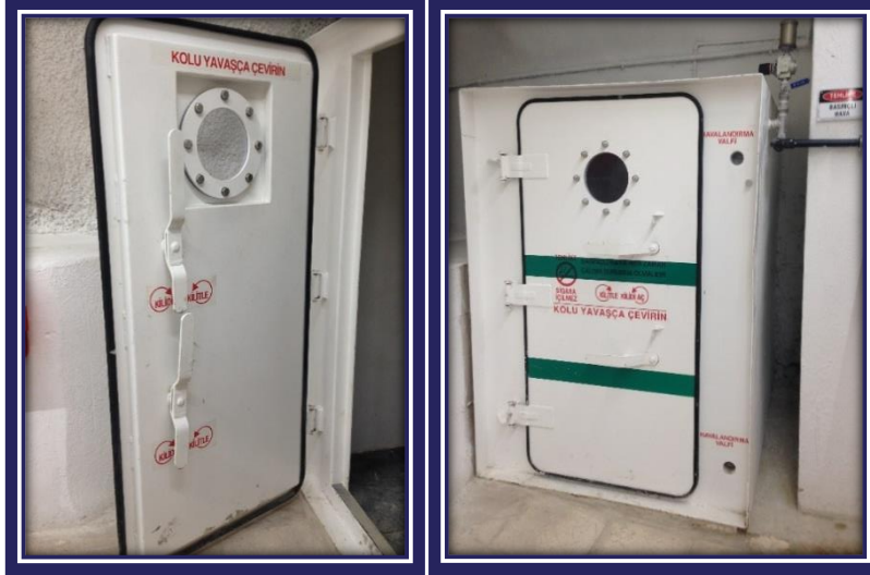
Şekil 9. Sığınma odası kapıları
