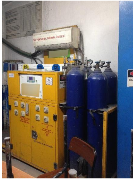
Şekil 4.10. Sabit sığınma odasında bulunan O 2 tüpleri
