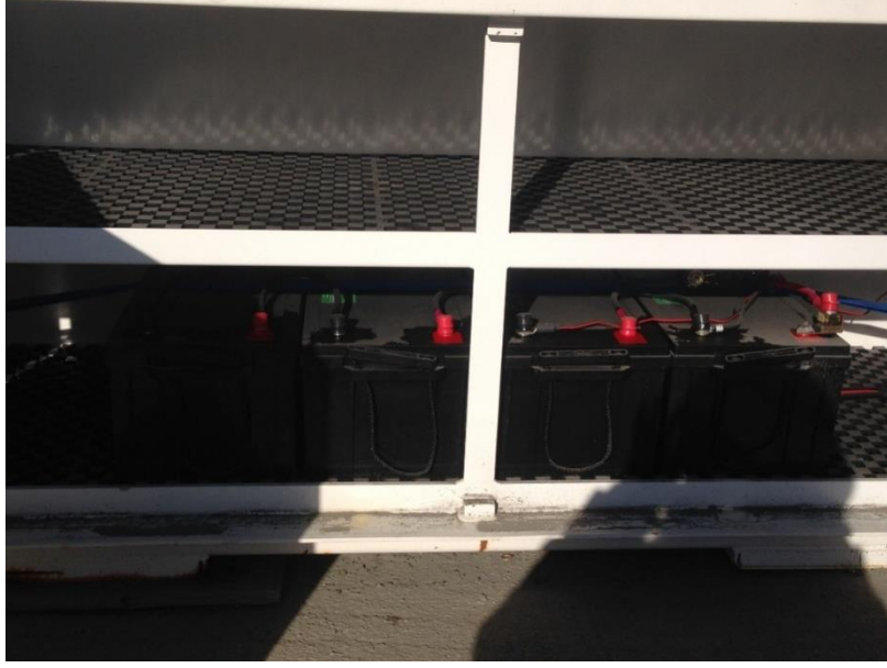
Şekil 4.12. Taşınabilir sığınma odasına ait kuru tip aküler
