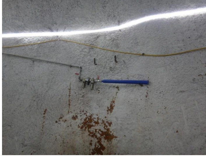
Şekil 4.21. Sabit sığınma odasındaki basınçlı hava borusu
