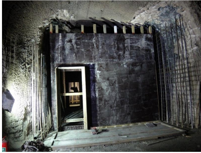
Şekil 4.17. İşletmede yapım aşamasındaki sabit sığınma odası
