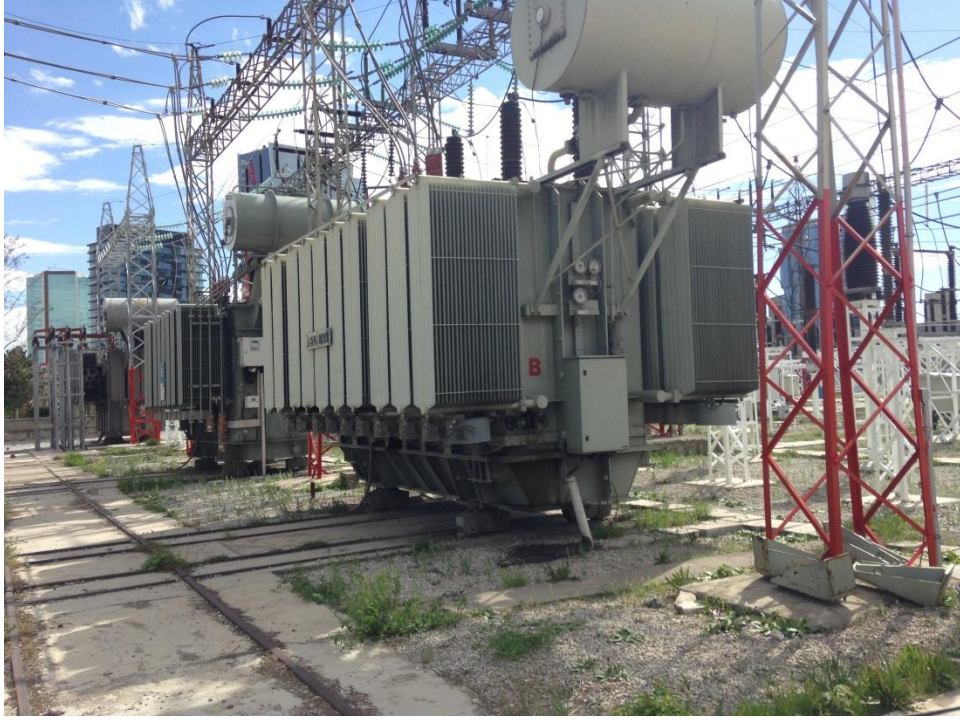
Şekil 9. Güç trafosu
