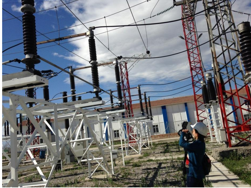
Şekil 17. Açık şalt sahasında cihazların termal ölçümü
