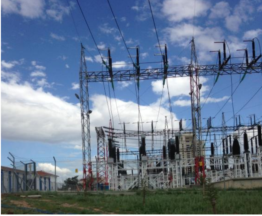
Şekil 13. Açık şalt sahası etrafında bulunan tel kafes
