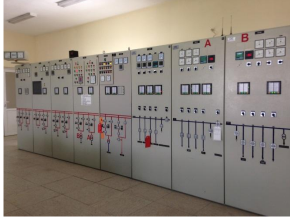
Şekil 30. AC ve DC panolar
