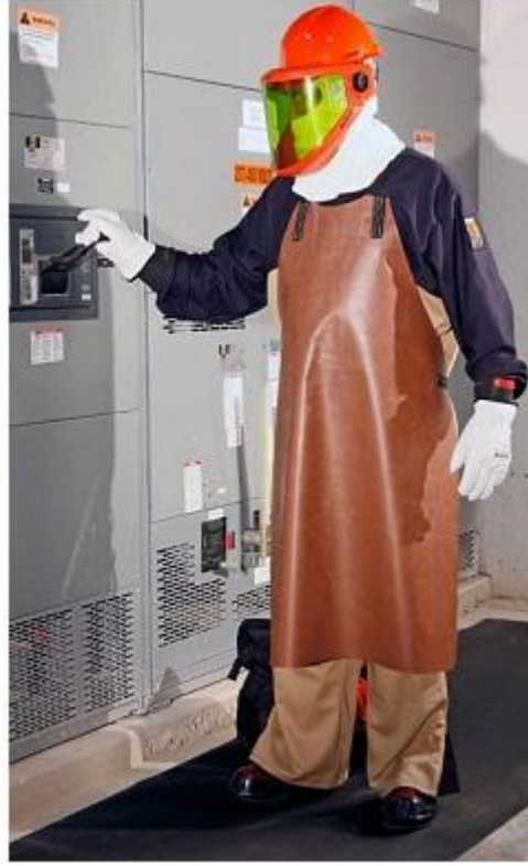
Şekil 37. Yüksek gerilim ile yapılan çalışmalarda KKD kullanımı
