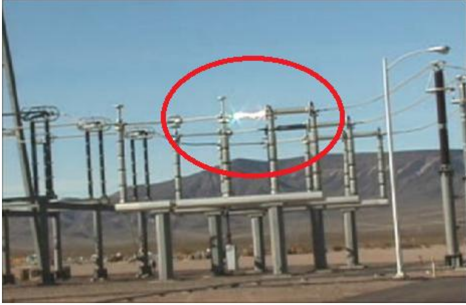
Şekil 29. Kesicide oluşan ark
