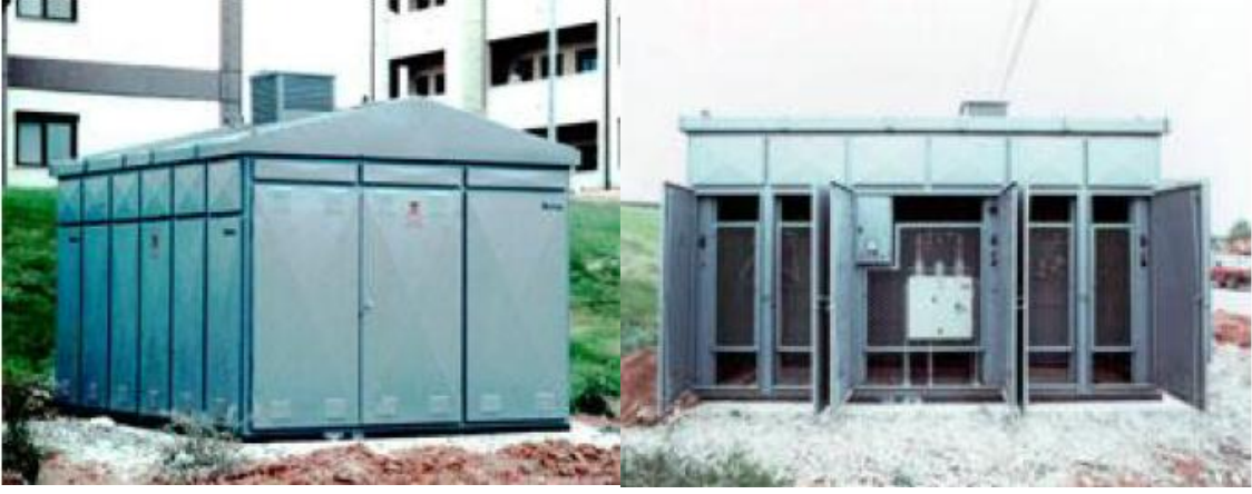
Şekil 4. Metal köşk tipi trafo merkezi [13]
