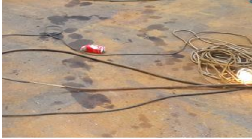
Resim 4.3. Uzatma kablolarının deforme olması
