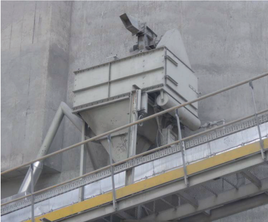
Resim 8. Toz tutucu kasede sahip ve tutulan tozu üretime geri boşaltma özelliği olan filtreler
