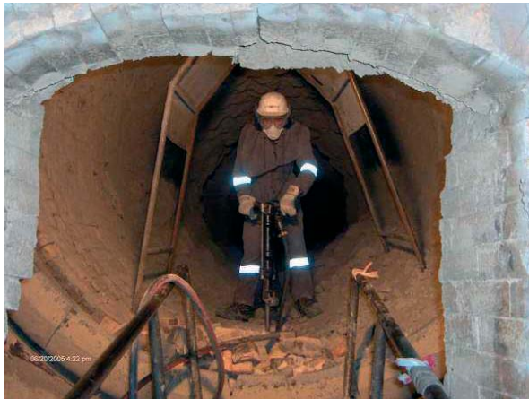
Fırın içi tuğla sökümü.
