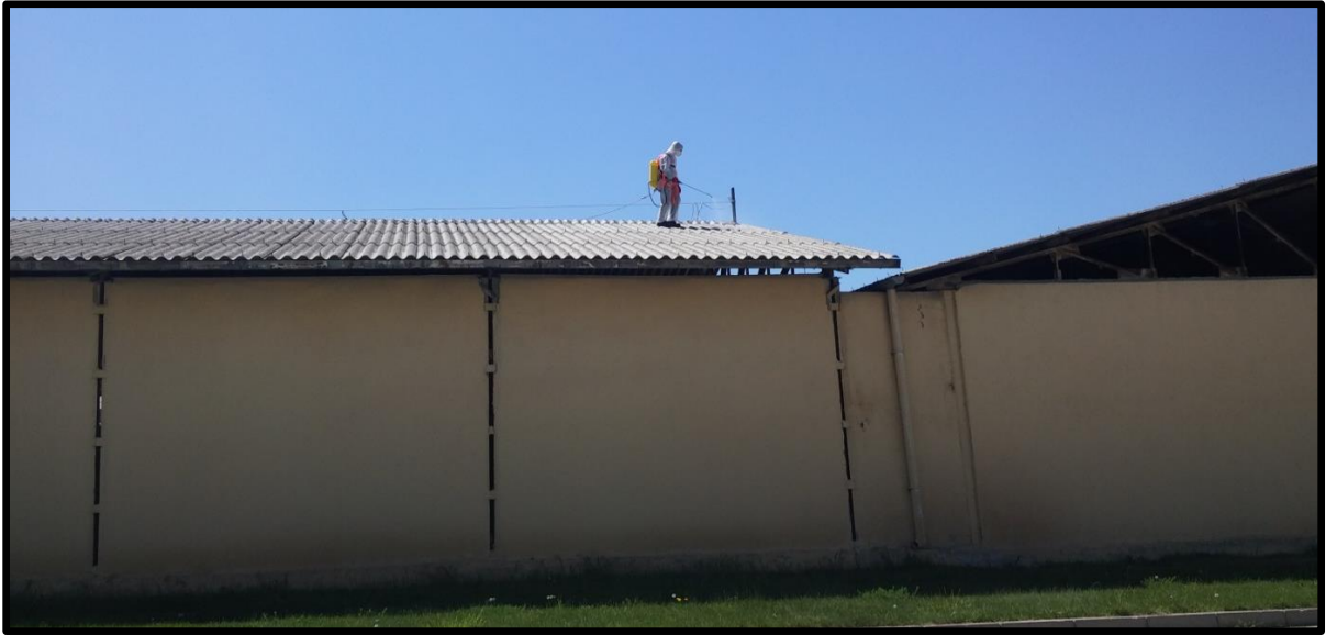
Resim 3.5. Söküm Sahası 3 - Asbestli çatı malzemesi sökümü (yapıştırıcı spleyenmesi)
