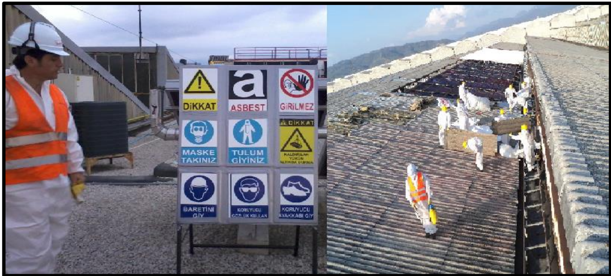
Resim 3.7. Söküm Sahası 4 - Asbestli çatı malzemesi sökümü
