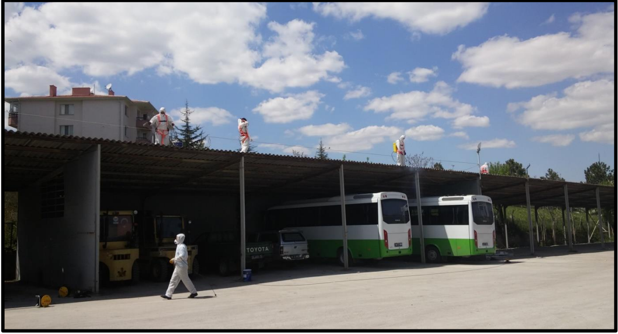
Resim 3.6. Söküm Sahası 3 - Asbestli çatı malzemesi sökümü
