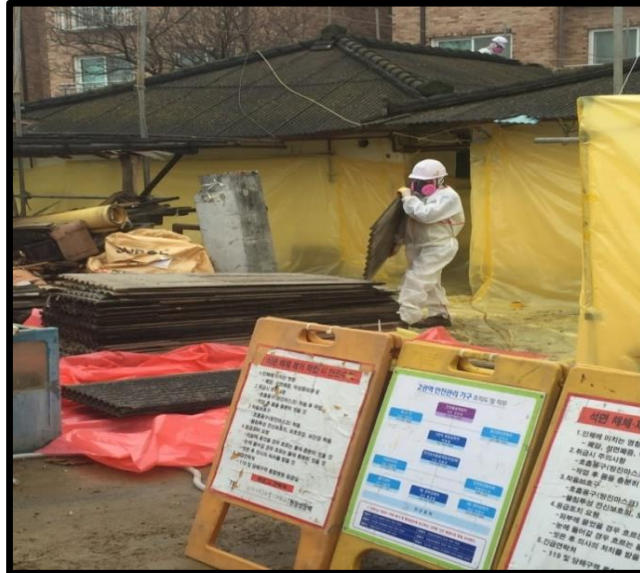
Resim 3.9. Söküm Sahası 5 - Asbestli çatı malzemesi sökümü
