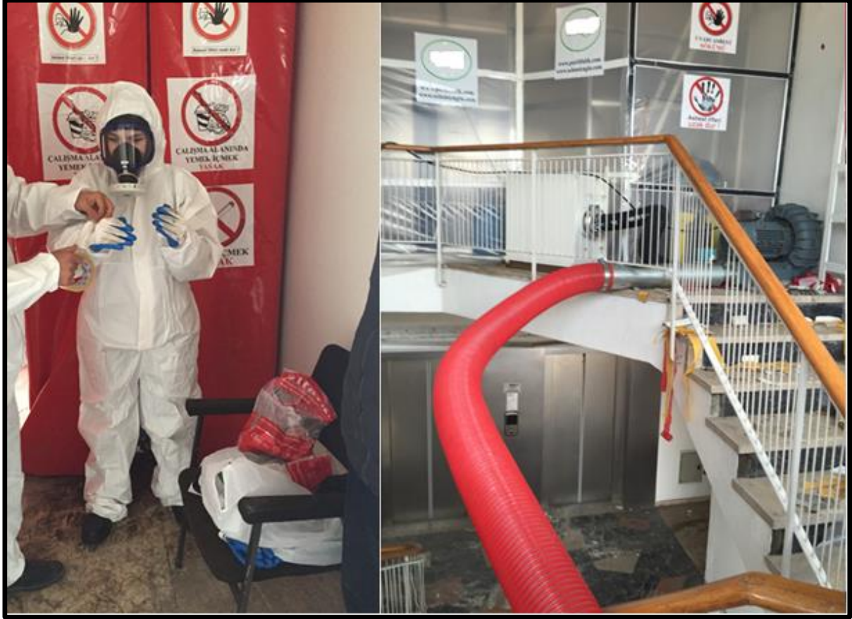
Resim 3.1. Söküm Sahası 1 - Asbestli izolasyon malzemesi sökümü
