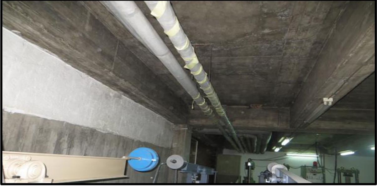
Resim 3.3. Söküm Sahası 2 - Asbestli izolasyon malzemesi sökümü (laboratuvar)
