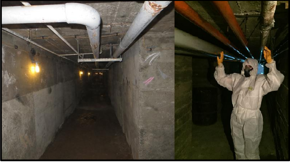
Resim 3.4. Söküm Sahası 2 - Asbestli izolasyon malzemesi sökümü (galeri)
