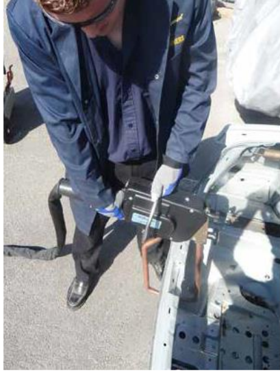
Şekil 6.1. Yeni bir paneli yerine sabitlemek için kullanılan el tipi spot kaynağı
