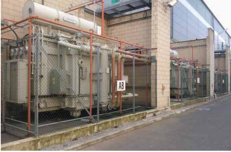
Şekil 3.4. Transformatör bölmeleri
