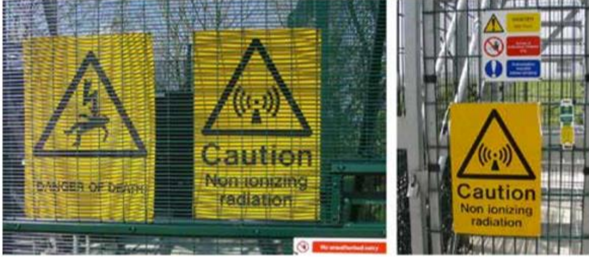
Şekil 12.4. Radar kapısı (solda) ve anten kulesinin kapısındaki uyarılar (sağda)
