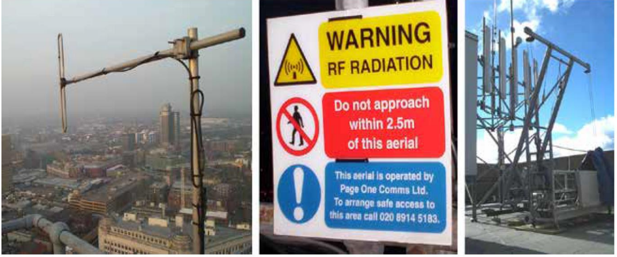
Şekil 10.6. a) Yürüme yoluna çok yakın bir çağrı sistemi anteni, b) Yerleştirilen yeni uyarı notu c) Mekanik durdurucu sayesinde, asma iskeleler artık antenlerin önüne kadar yükseltilemez
