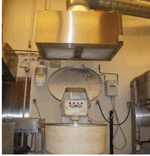
Resim 2.5. Lokal havalandırma sistemi bulunan hamur yoğurma makinesi [34]
