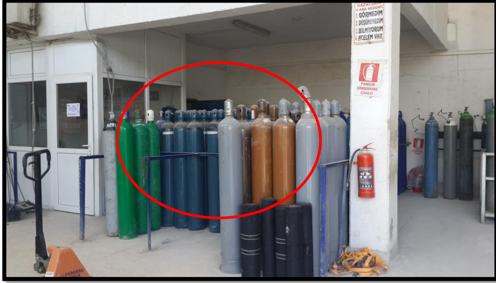
Resim 4.11. Uygunsuz istiflenen basınçlı gaz tüpleri
