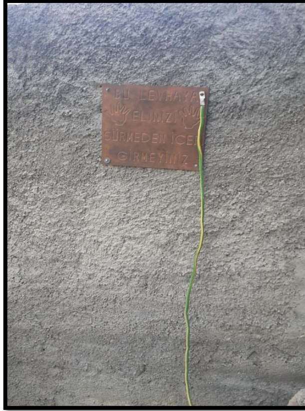
Resim 4.5. Topraklama levhası
