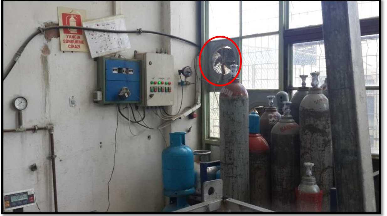
Resim 4.7. Ev tipi fan kullanımı
