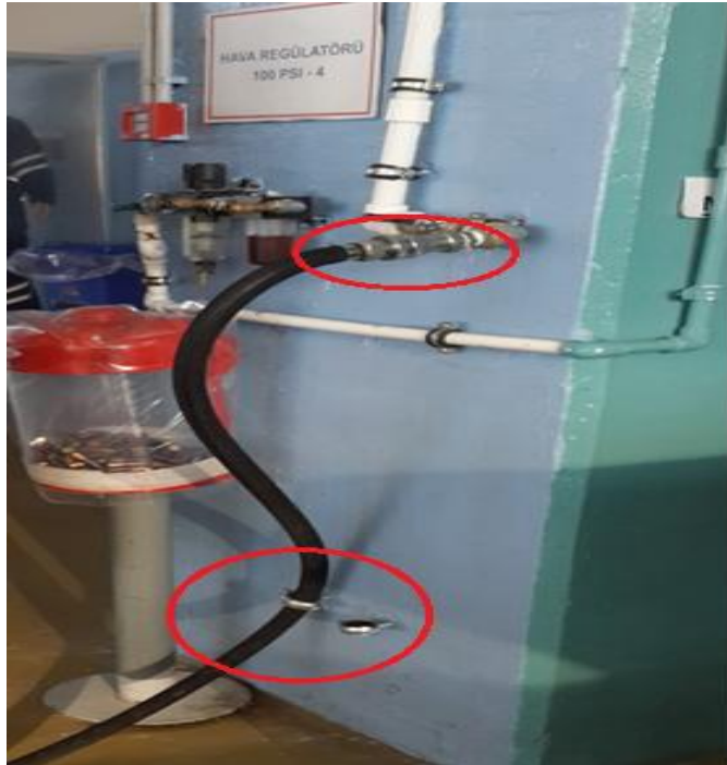
Şekil 42. Basınçlı hava hortumunun duvara sabitlenmesi
