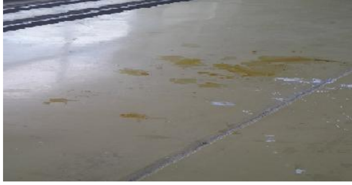
Şekil 20. Kimyasal yağın akmasıyla kayganlaşmış zemin
