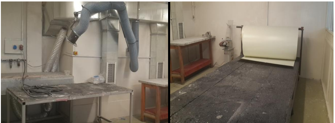
Şekil 31. Tozlu odada yetersiz havalandırma
