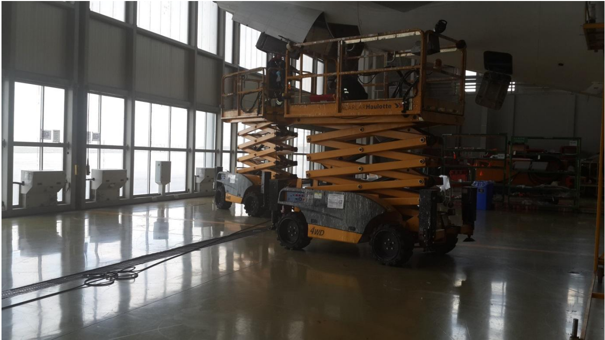
Şekil 7. Yüksekte çalışmada elektrikli yükseltilebilen seyyar iş platformu kullanımı
