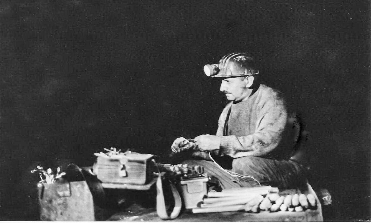
Resim 4.6. İkinci işletmede dinamit yemleme işlemi
