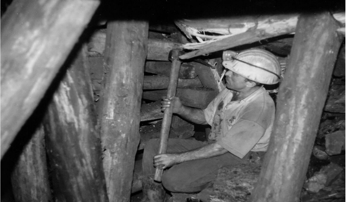
Resim 4.7. İkinci işletmede ocak içerisinde tahkimat taraması
