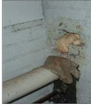
Şekil 11. Açık alanın köpükle kapatılması
