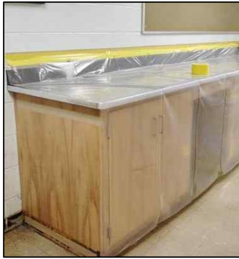
Şekil 24. Taşınmaz malların kaplanması
