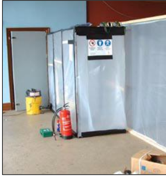
řekil 17. Geiř sistemlerinde hava kilitlerinin kullanımı
