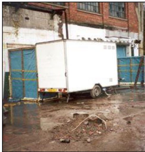
řekil 18. Duř nitesinin karantina alanına direkt bađlanması
