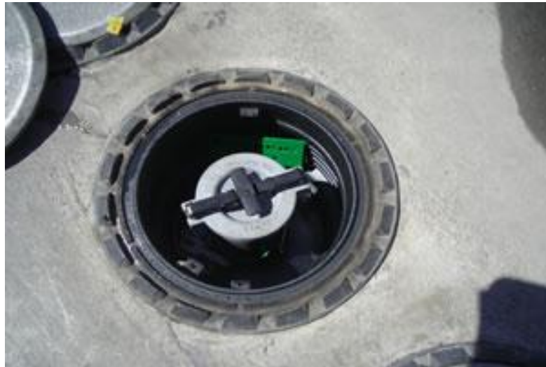
Şekil 14. Yer altı tankı ağzı
