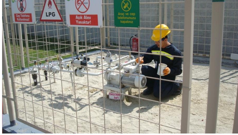
Şekil 16. LPG depolanması ve uyarı işaretleri
