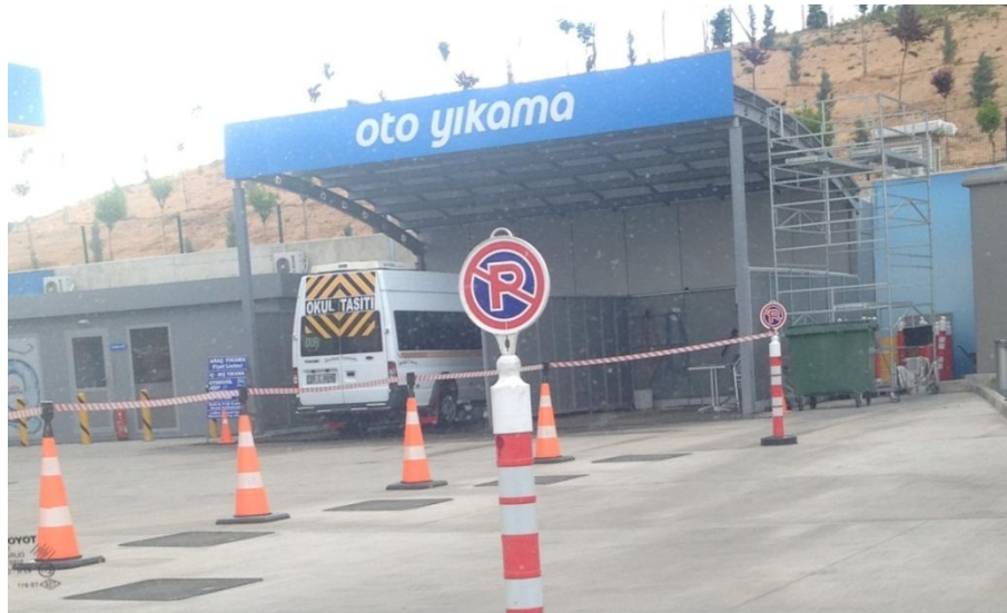
řekil 36. Uygun řekilde kapatılmıř tank alanı
